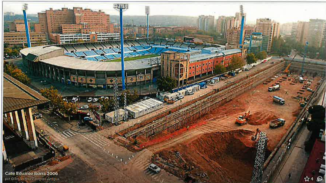
CONSTRUCCIÓN DEL ESTACIONAMIENTO PÚBLICO DEL PASEO DE EDUARDO IBARRA EN 2006
