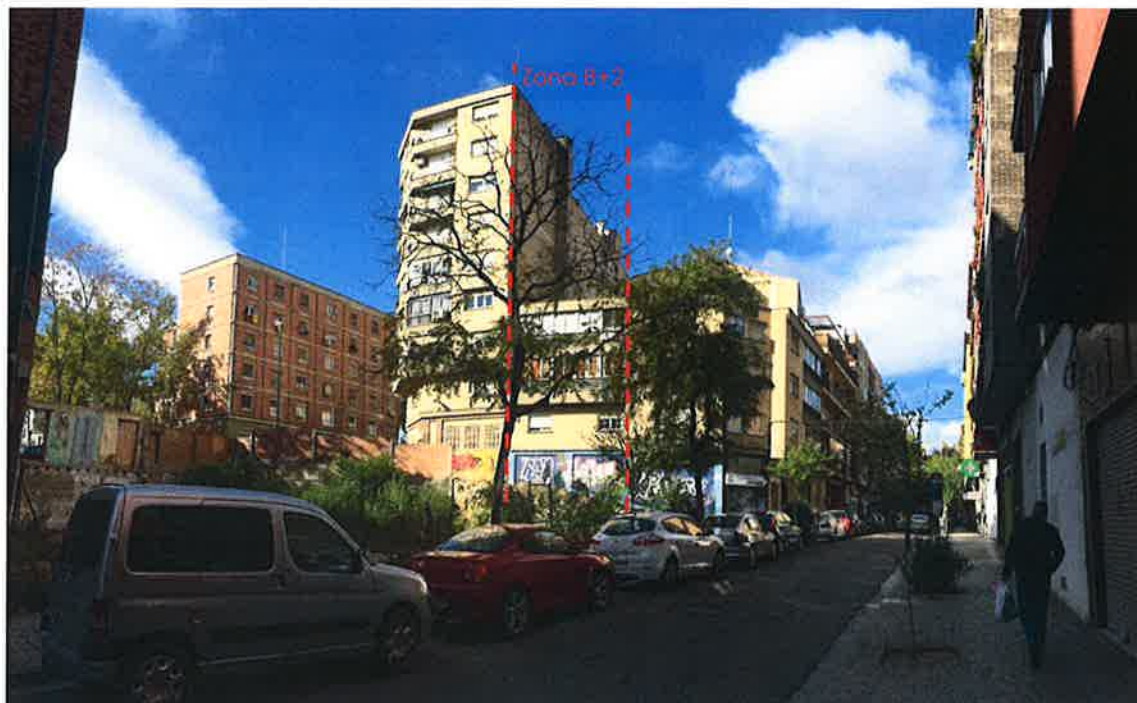
FOTOGRAFÍA 5. (Vista del frente a la C/ Lapuyade y edificio enfrentado en C/ Maestro Chueca)
