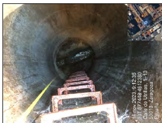
POZO MSLINK 34790- POZO NUEVO PASO A Ø40 CM
