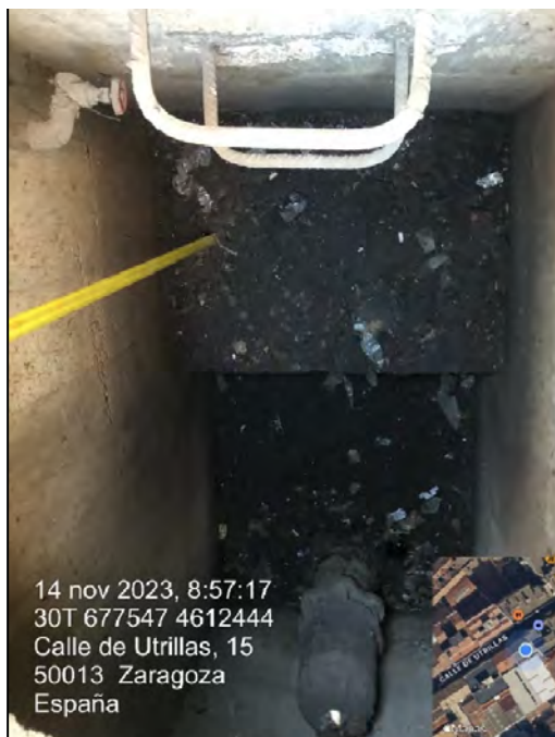
CÁMARA DESCARGA COLECTOR HACIA F. BALLESTEROS
