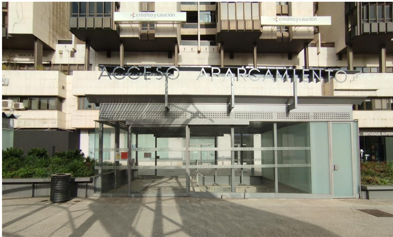
FOTOGRAFÍA DE CASETÓN DE COMUNICACIONES PEATONALES EN EJECUCIÓN EN PLAZA SALAMERO
