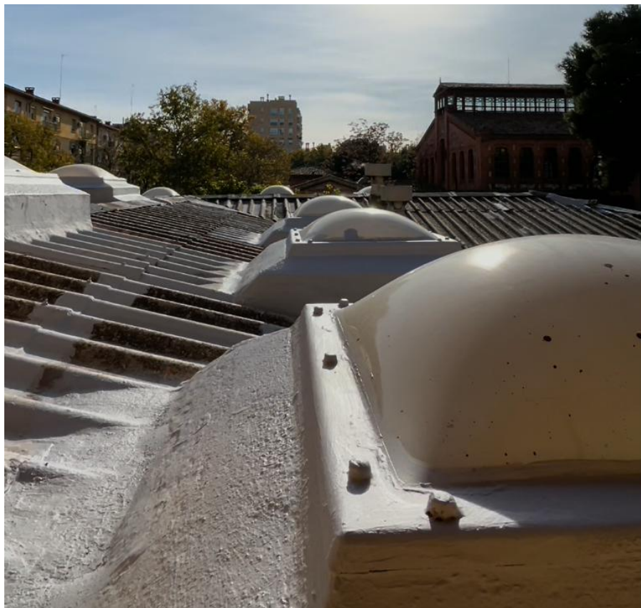
Imagen 9: Foto de la cubierta inclinada y las claraboyas
