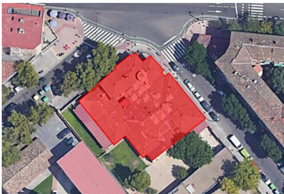
Imagen cubierta con amianto a dismantelar
