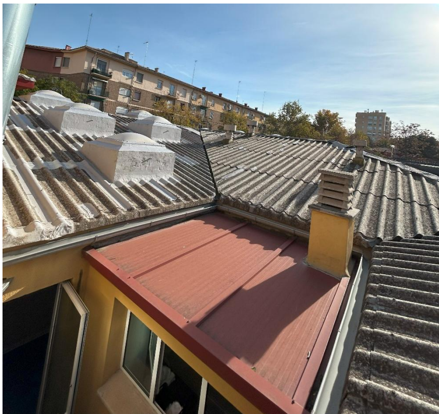
Imagen 8: Foto de la cubierta inclinada, en su encuentro con el patio
