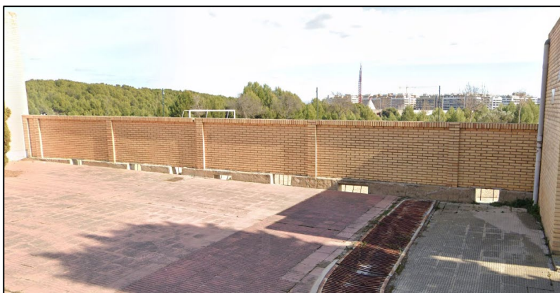
Ilustración 13. Vista de las 'gateras' de drenaje desde el interior del Cementerio.
