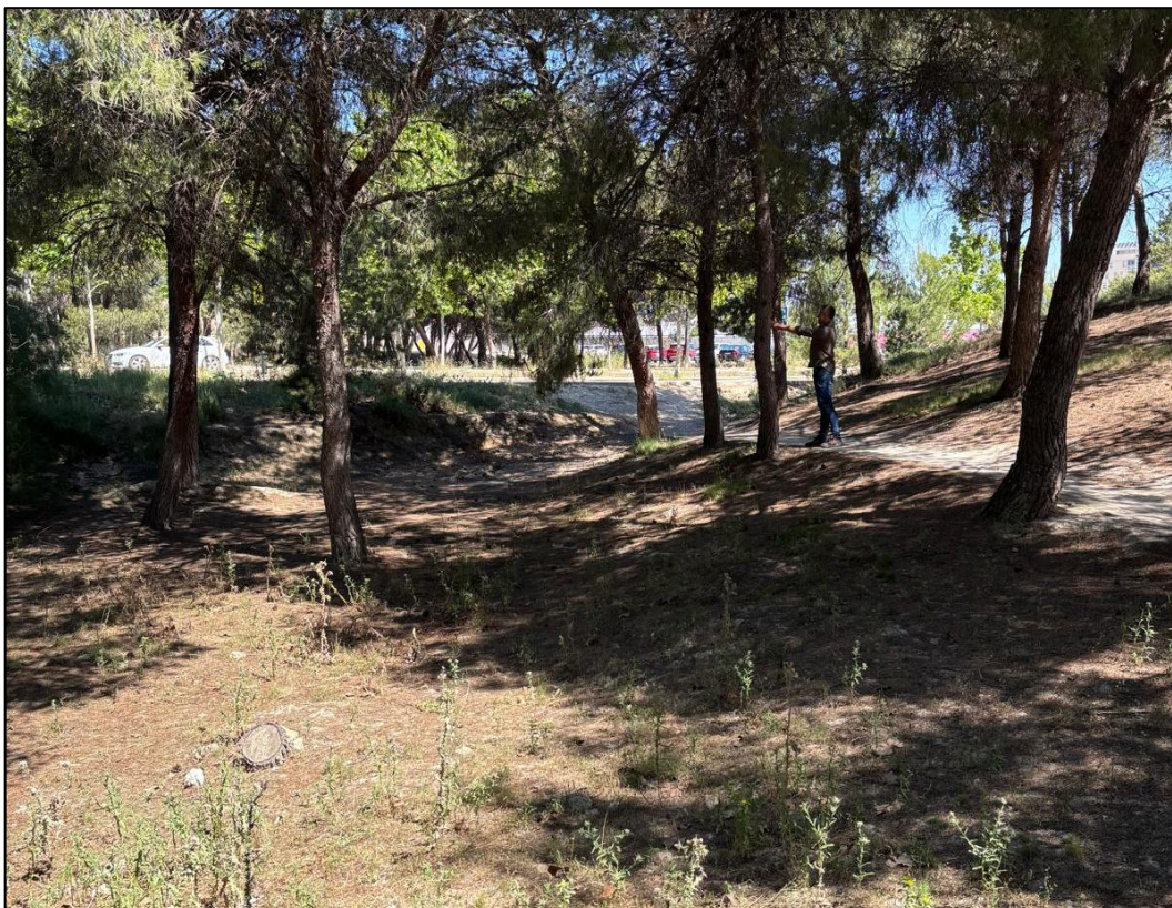
Ilustración 3. Emplazamiento del nuevo dique inferior de laminación. Al fondo, vial de la Av. de Puerto Venecia.
