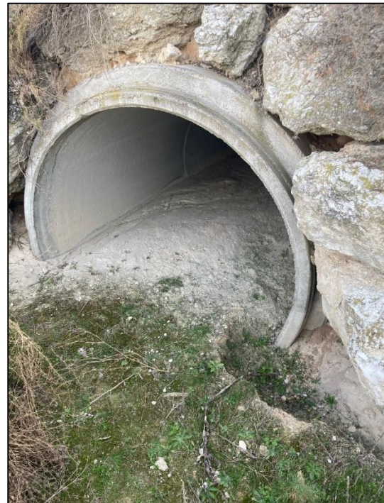
Ilustración 7. A la izquierda, sección de aguas arriba de la conducción existente de 1800 mm de DN. A la derecha, sección de aguas abajo. Dique superior este.
