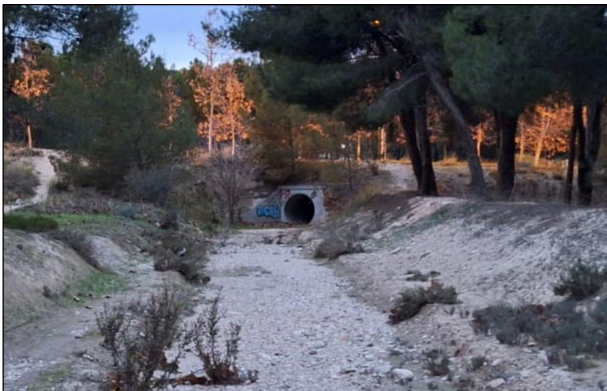
Ilustración 20. Vista desde aguas arriba del canal y obra de fábrica de la conducción de 1800 mm de DN.
