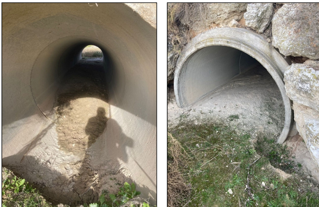
Ilustración 11. A la izquierda, sección de aguas arriba de la conducción existente de 1800 mm de DN. A la derecha, sección de aguas abajo. Dique superior este.
