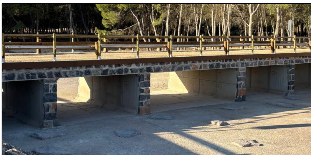
Ilustración 49. Vista del aplacado de los marcos y aletas del canal perimetral del barranco de la muerte (fase I del proyecto).
