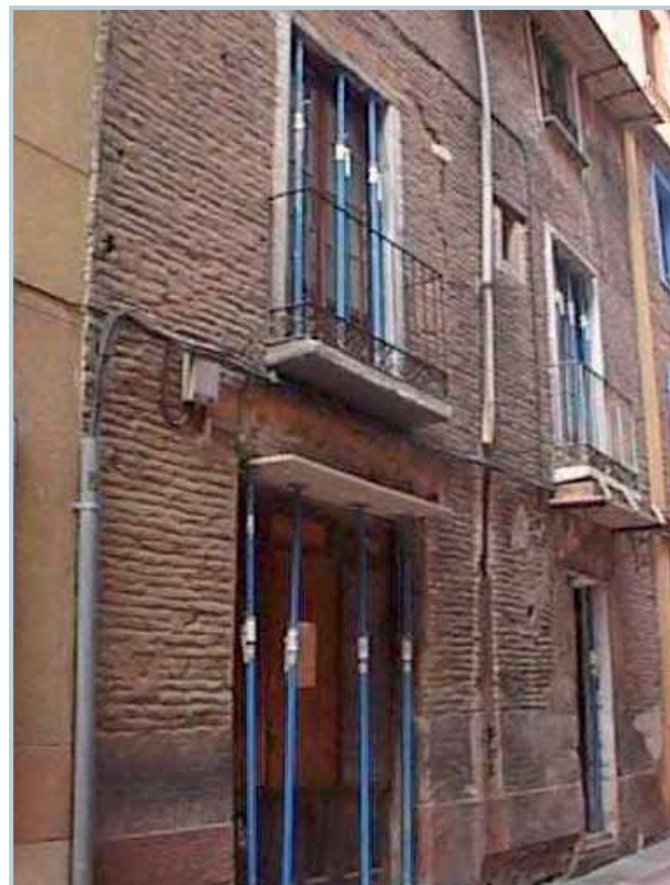
Edificio calle Eras
