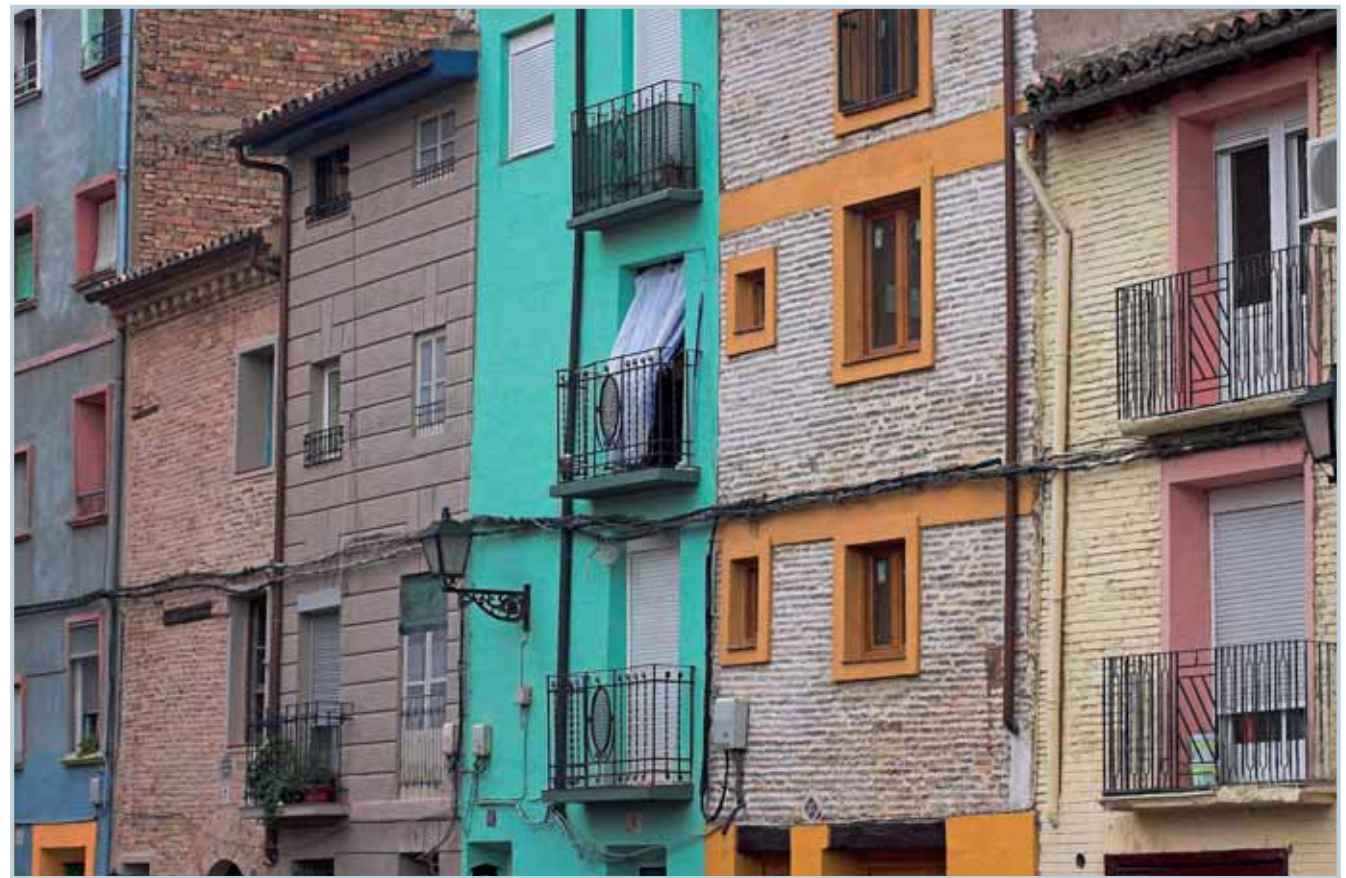
Fachadas edificios rehabilitados / Foto: F. Mateo
