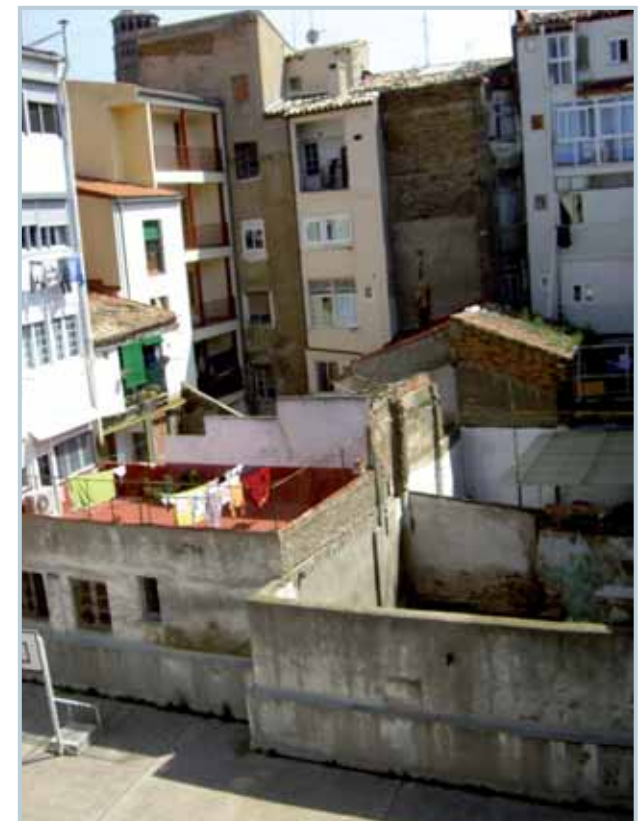
Patio manzana sin ordenar
