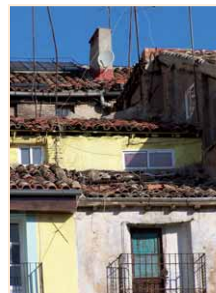
Edificio calle Casta Álvarez
