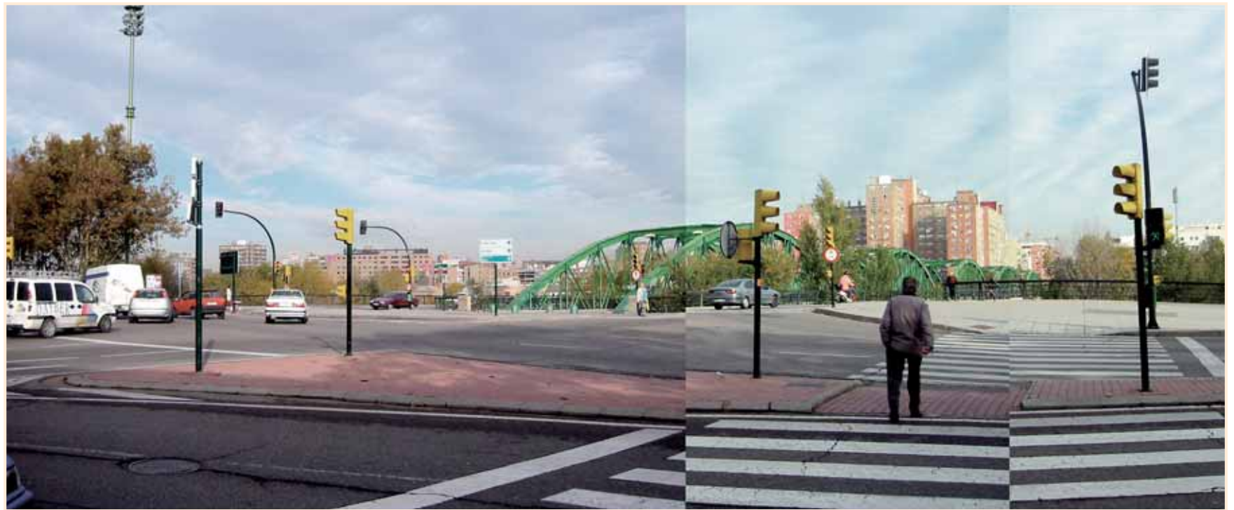
Escena urbana Tenerías. Estado actual
