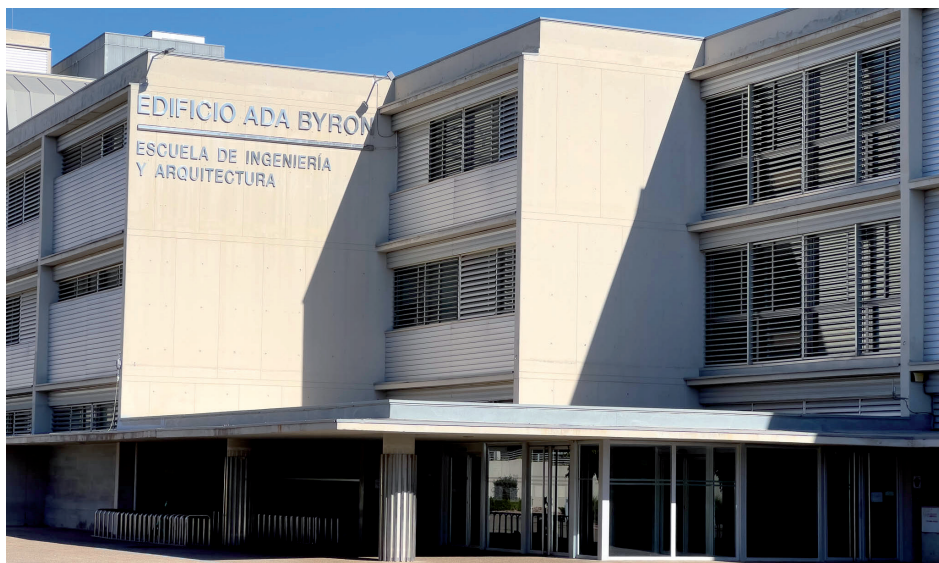
Campus Río Ebro. Escuela de Ingeniería y Arquitectura. Edificio Ada Byron
