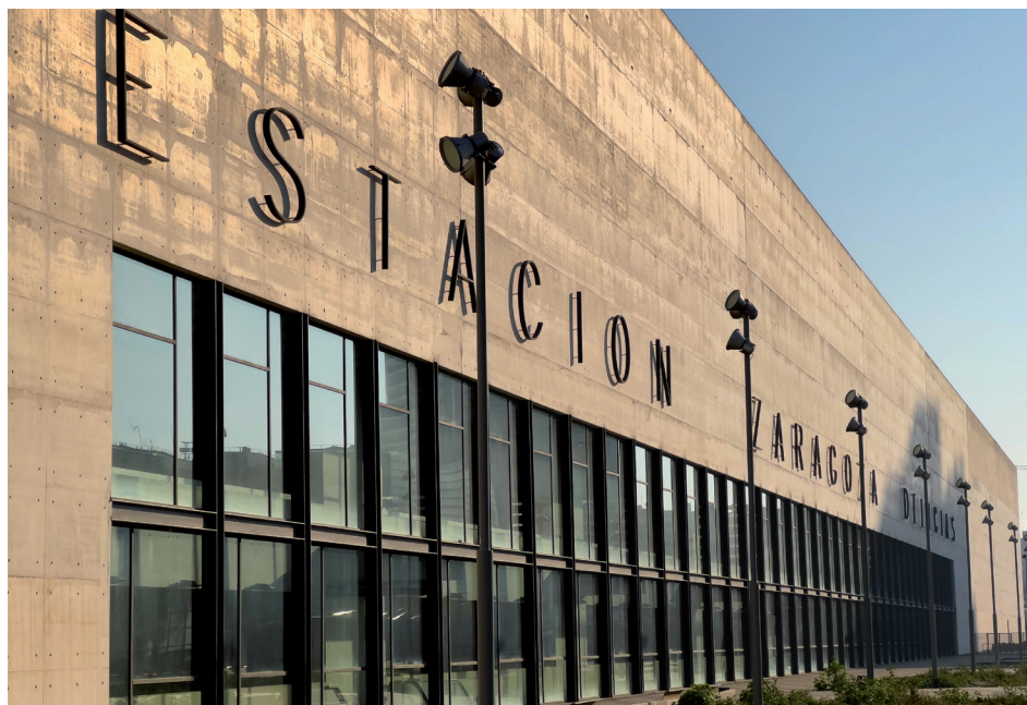
| Exterior de la estación intermodal de Zaragoza-Delicias |
