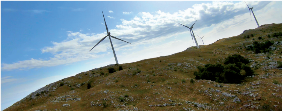
| Aerogeneradores de un parque eólico |
