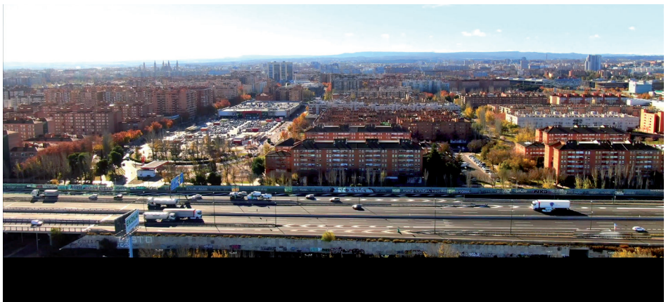
Vista aérea de la A-2 a su paso por Zaragoza
