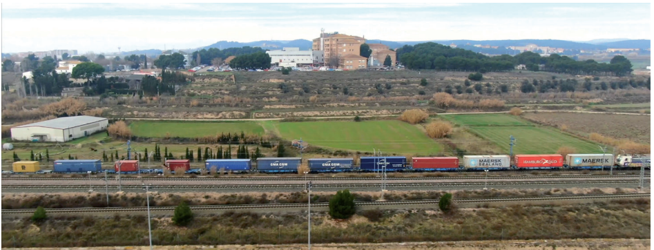
Nodo ferroviario al norte de la ciudad de Zaragoza
