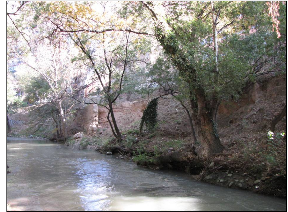
En los taludes situados junto al río se observan restos de muros entre la vegetación
