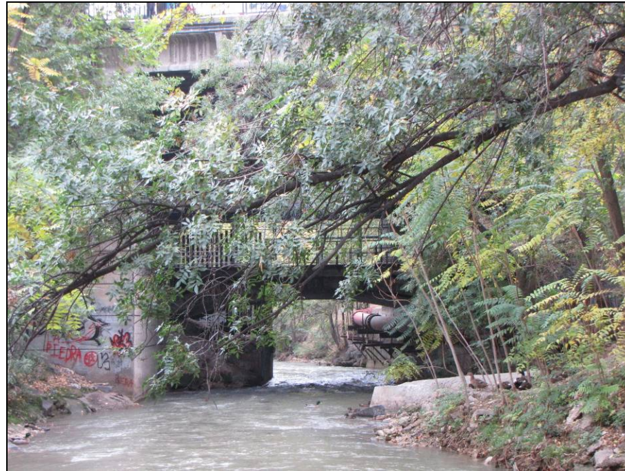
En la foto se observa por debajo del puente la tubería roja descrita
