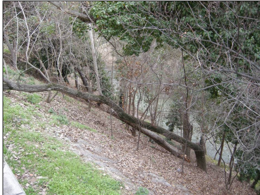
Detalle de árboles caídos en los taludes
