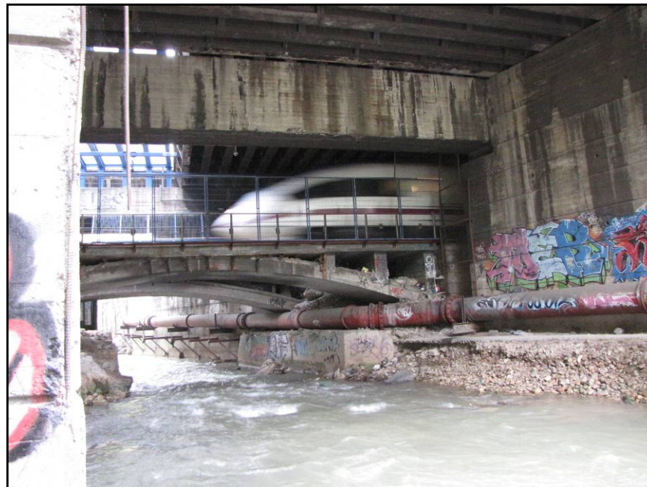
Imagen tomada del paso del tren por debajo del puente así como de la tubería de saneamiento
