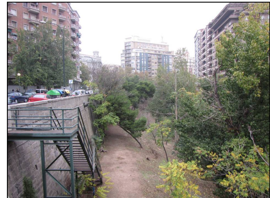
Escalera metálica de acceso al río y vista de la vegetación existente
