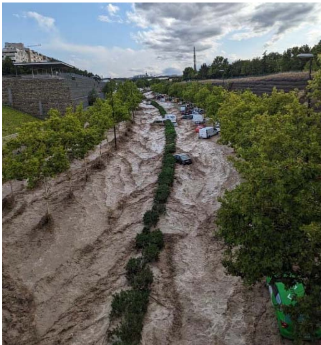
Inundación observada en la Z-30 inmediatamente aguas arriba del antiguo trazado del Canal Imperial.
