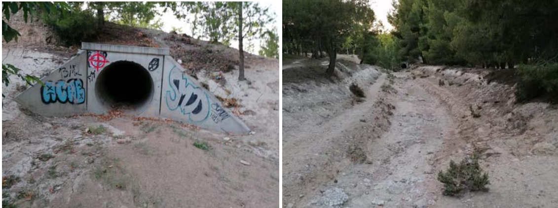
Arriba: intercepción del barranco del Camino de Arráz por la carretera de circunvalación Z-40. Abajo: intercepción por la Avenida de Puerto Venecia.
