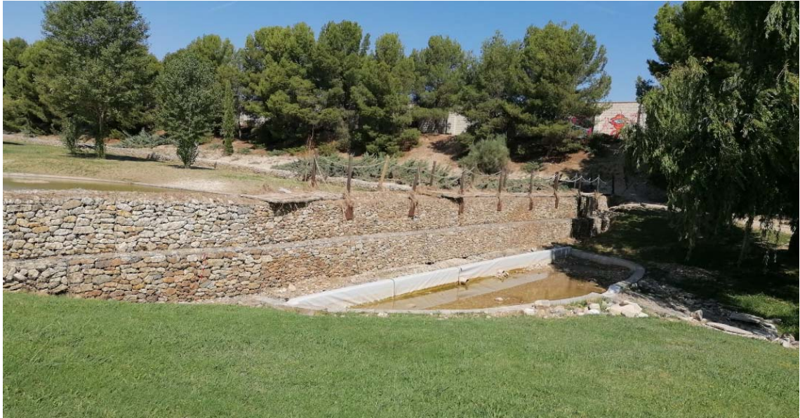
Dique aguas abajo. Cota coronación variable. Mínima 254.51 msnm.
