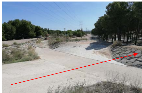
Vado del camino donde se ubicaría el dique.
