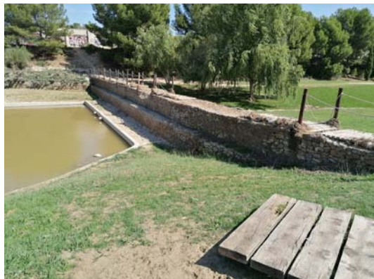
Elementos de laminación de avenidas construidos en el Parque del Barranco. Arriba: cola del vaso (izquierda) y paramento de aguas abajo del dique de aguas arriba (derecha). Abajo: Vaso (izquierda) y dique de aguas abajo (derecha).
