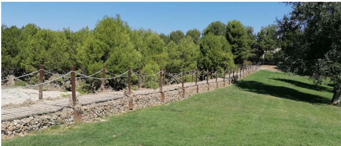
Dique aguas arriba. Recogido en el MDT. Cota coronación variable. Mínima 258.4 msnm
