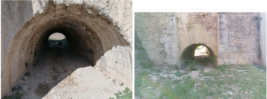
Antigua O.D.T. en el antiguo trazado del Canal Imperial sobre el barranco de la Muerte.
