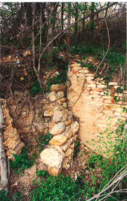
Restos de muro en la salida del manantial
