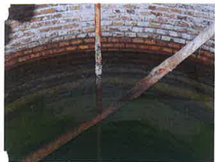
Interior del pozo, donde se aprecia la roca de donde surge el manantial y la tubería de elevación
