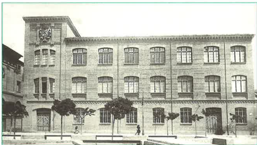
Fachada posterior del edificio en construcción destinado a La Caridad, 1908.
