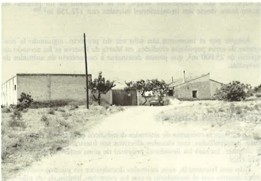
La cabañera. Antigua paridera transformada en guardería canina. (Mtes. Torrero).
