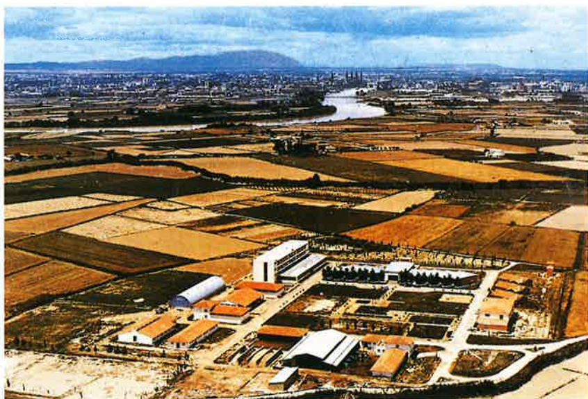
Escuela de capacitación agraria de Movera. La proximidad al campo e instalaciones ganaderas, permiten las prácticas a los alumnos.
