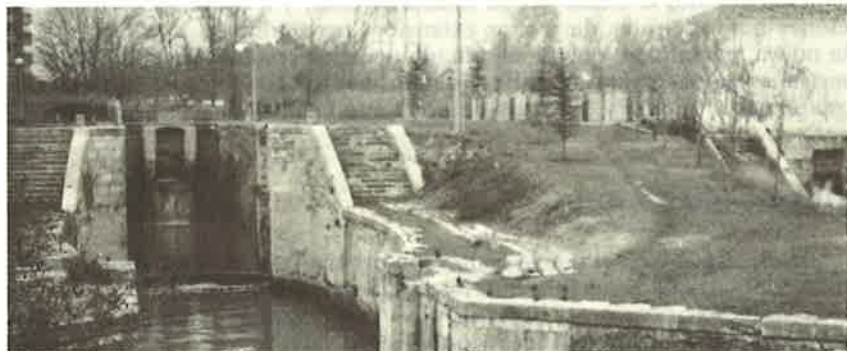
Además de los agrarios, el Canal tiene también aprovechamientos industriales. Salto y central hidroeléctrica de Casablanca.
