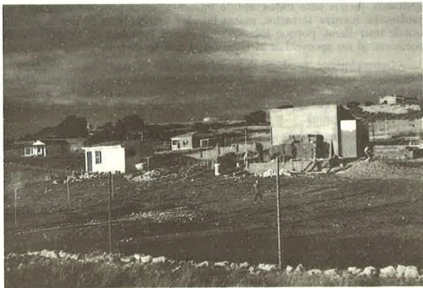
Edificaciones de baja calidad, con predominio de casa molinera sencilla y cobertizo con porche. (Parc. Bosque Alto).
