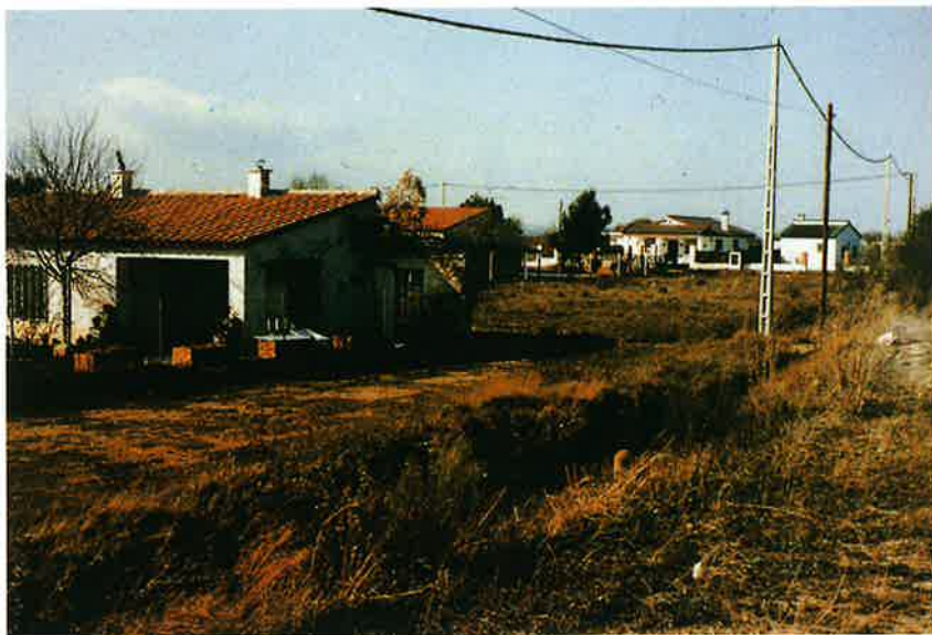
Falta de consolidación, de urbanización y riesgo por los tendidos aéreos (El Saso. San Mateo de Gállego).
