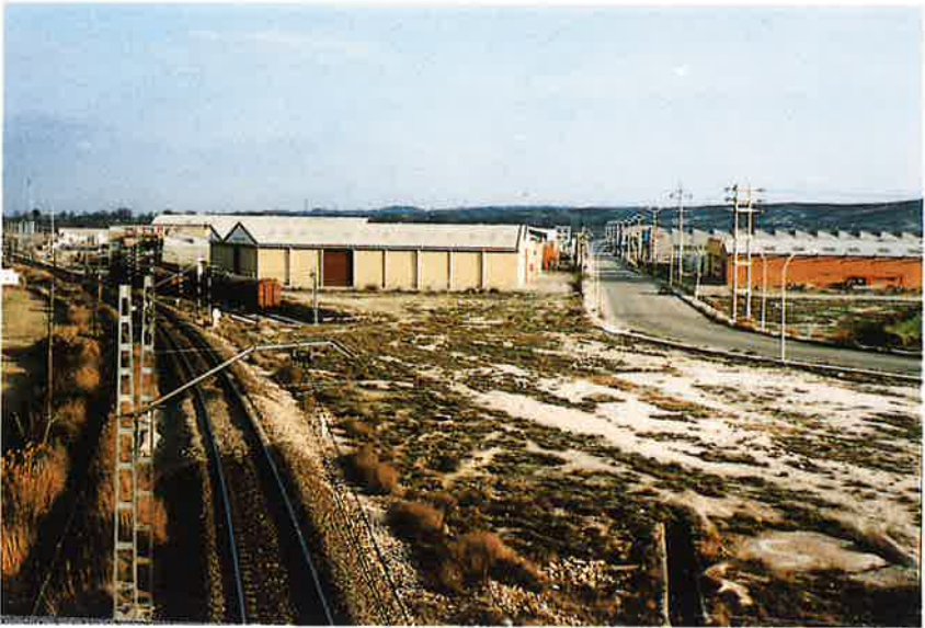
Las posibilidades que crea el ferrocarril influyen en el emplazamiento industrial. (Polígono Insider o La Cartuja).
