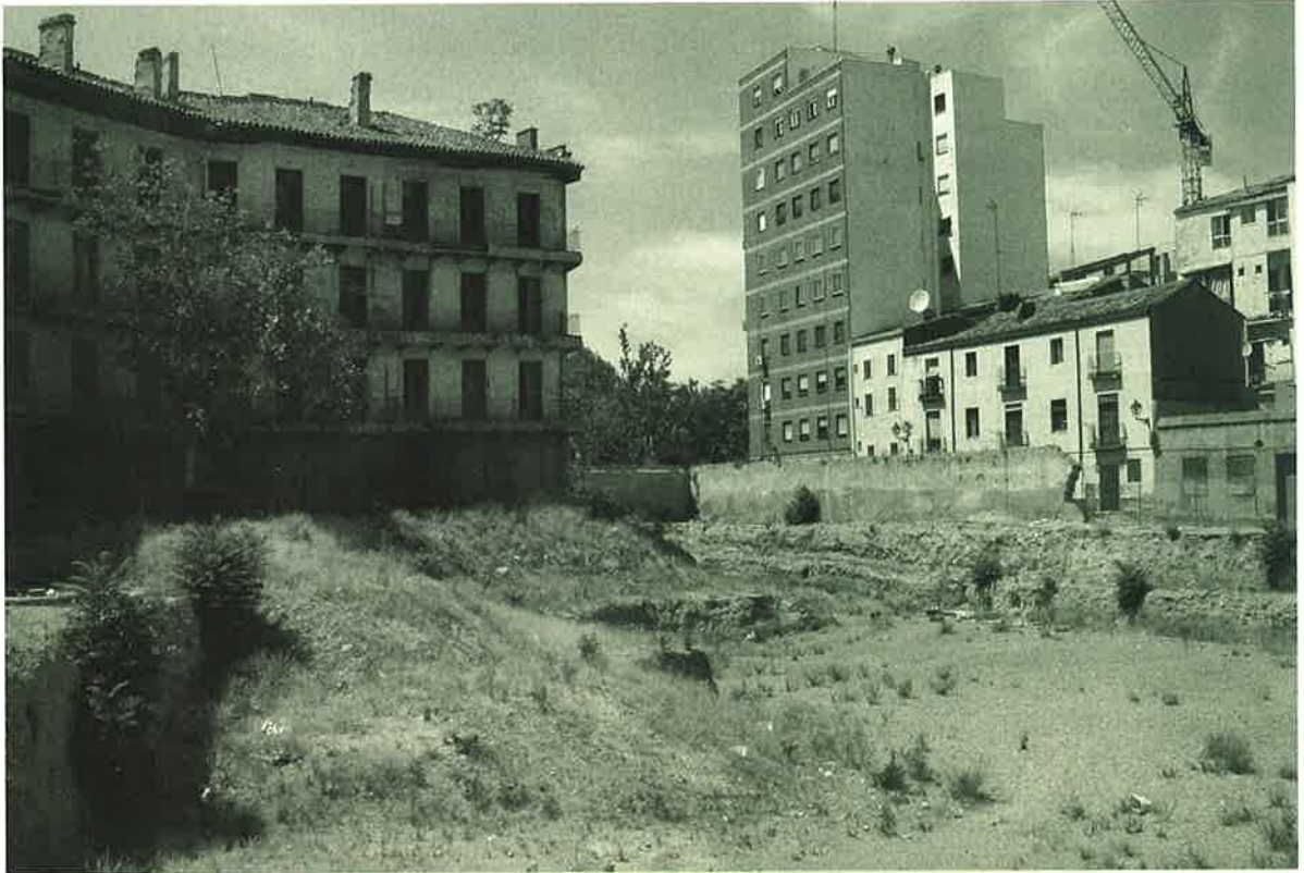
Solar en el antiguo Cuartel de Pontoneros donde se han descubierto unas ruinas islámicas del siglo XI
