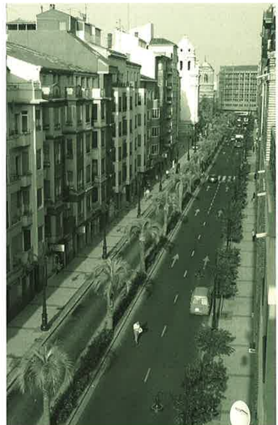
La calle Conde Aranda tras la reforma
