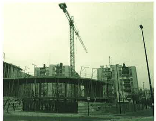
Obras en las esquinas del Psiquiátrico
