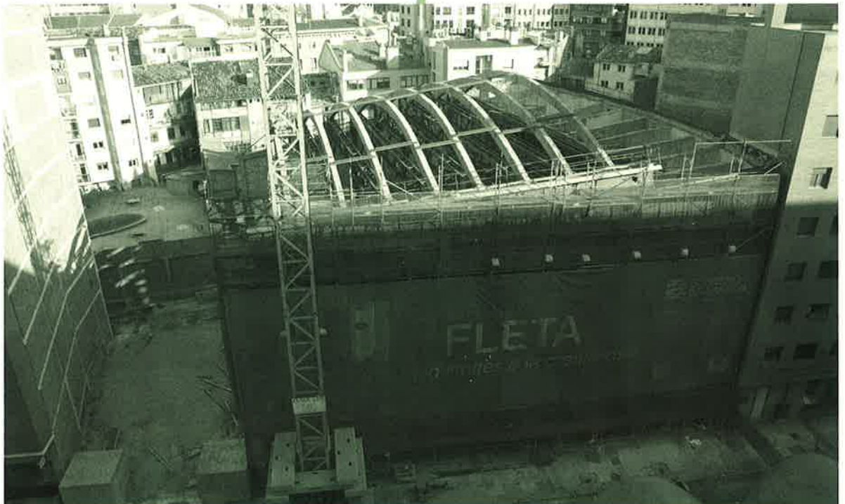
Las obras del Teatro Fleta
