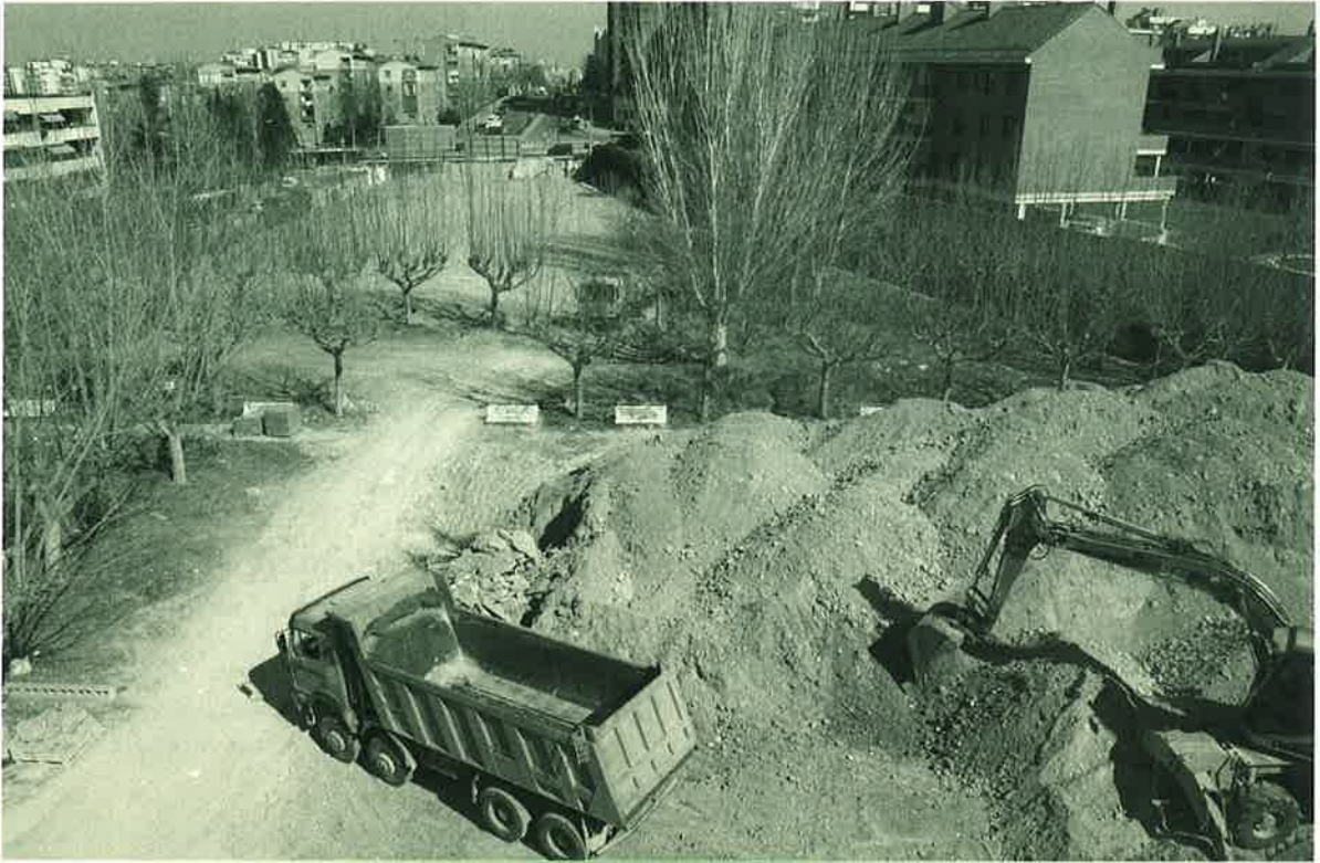
Demolición del edificio del Stadium Delicias
