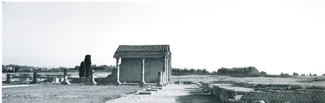
Figura 3. Estado actual y fotomontaje del ángulo sudoeste del ambulacro y del ala este del criptopórtico que rodeaba la zona religiosa del foro.
