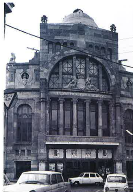
Fachada del Teatro Principal de Terrassa, 1911. Estado en 1975 (fot. Francesc Català-Roca).
