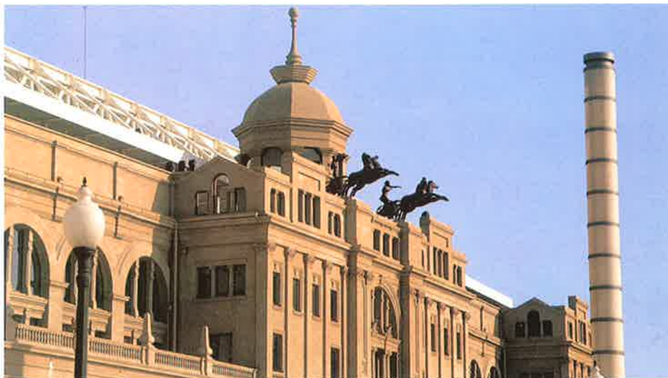
Bigas , 1929. Nueva fundición en poliéster, 1989. Fachada principal Estadio Olímpico de Montjuich, Barcelona (fot. Ferran Freixa, Lluís Casals).
