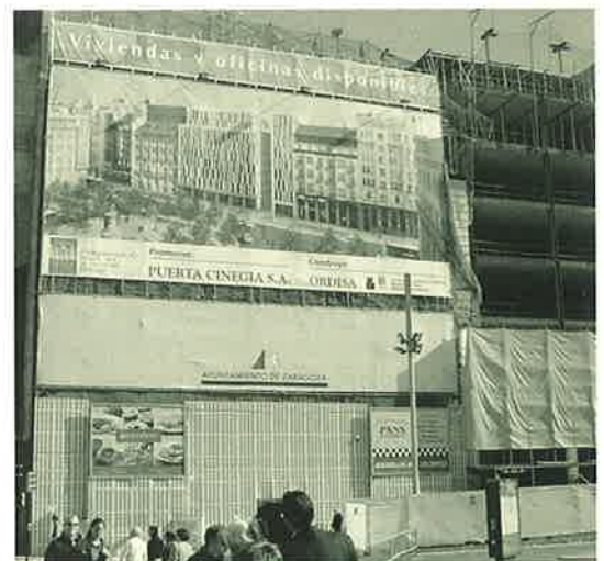
Obras del centro comercial en El Tubo
