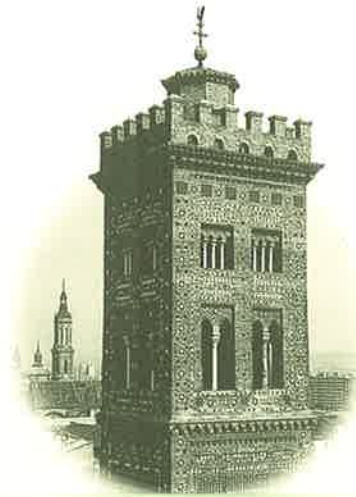
Torre de la iglesia de Sta. Mª. Magdalena (detalle)
