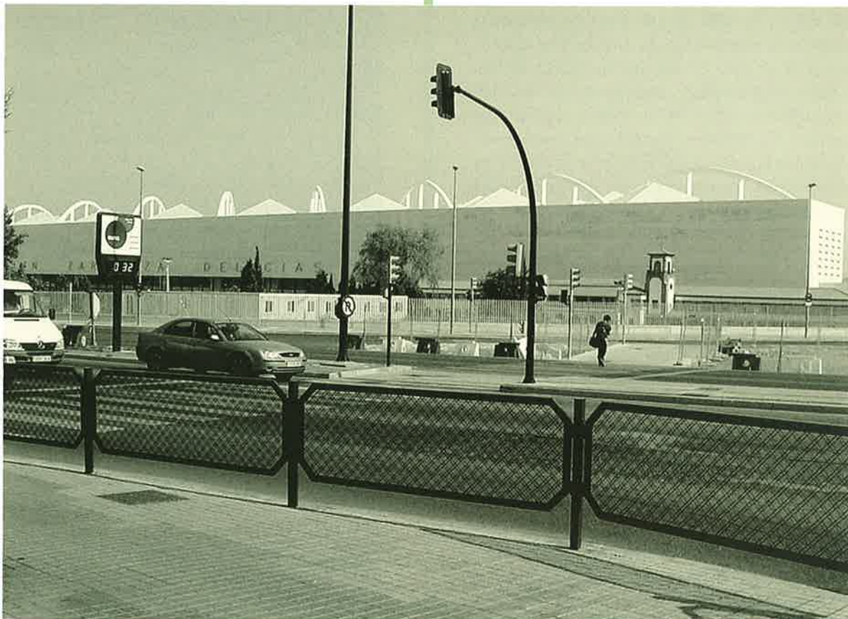
Acceso a la estación Zaragoza Delicias desde la avenida de Navarra
