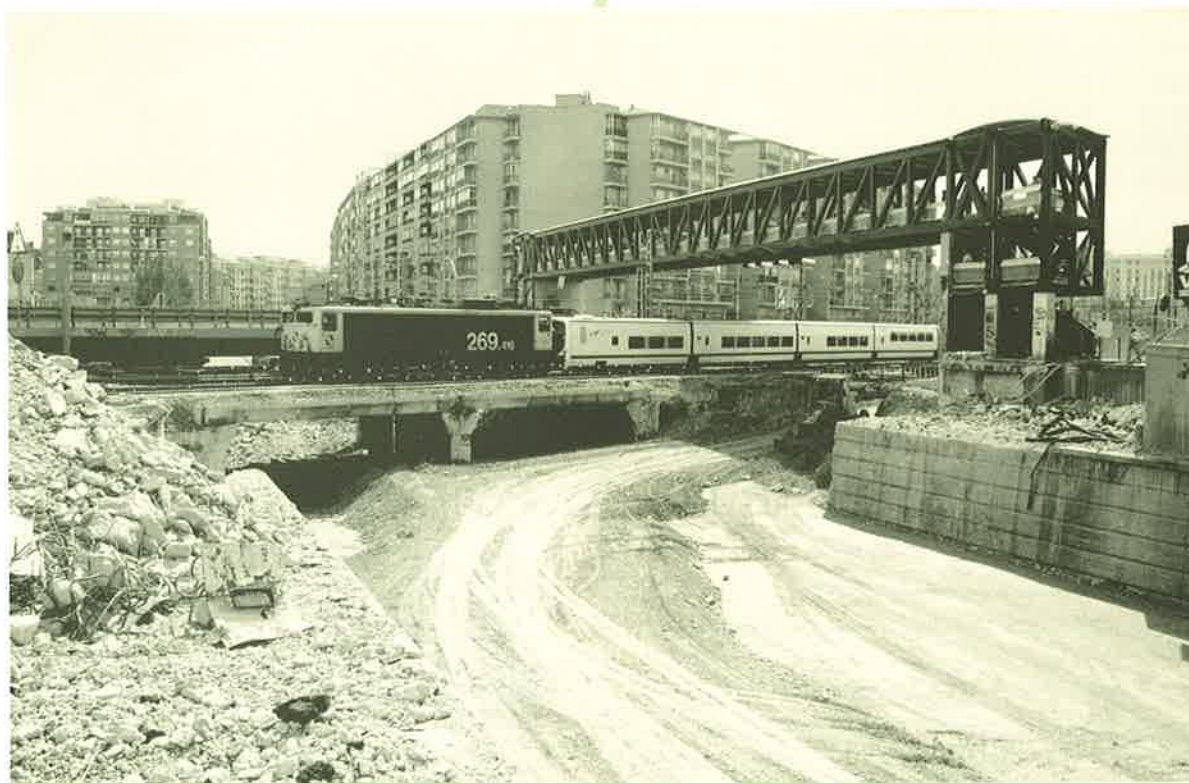
Obras de demolición del paso a nivel de Las Delicias
