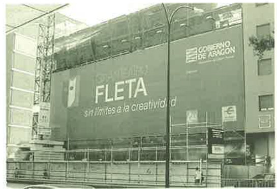
Obras en el Teatro Fleta
