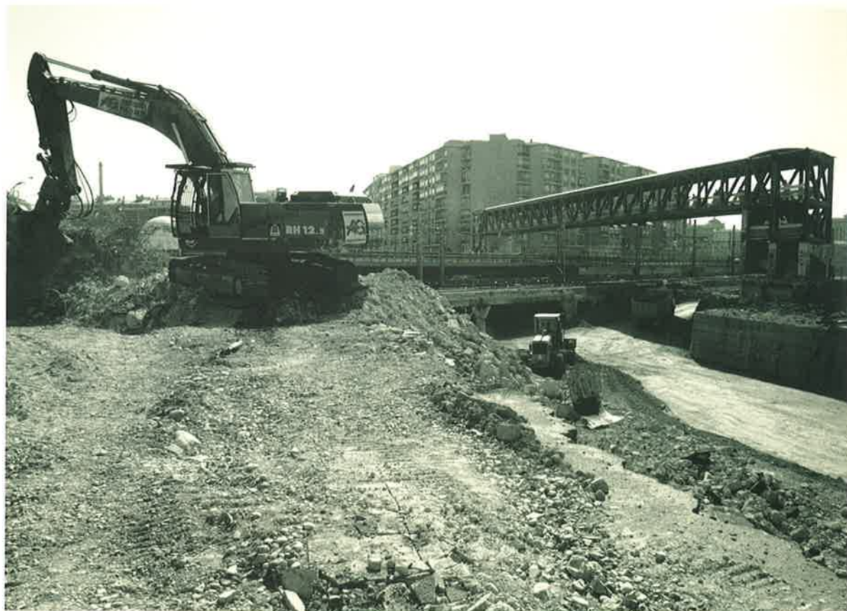
Obras del AVE en el antiguo paso a nivel de Las Delicias
