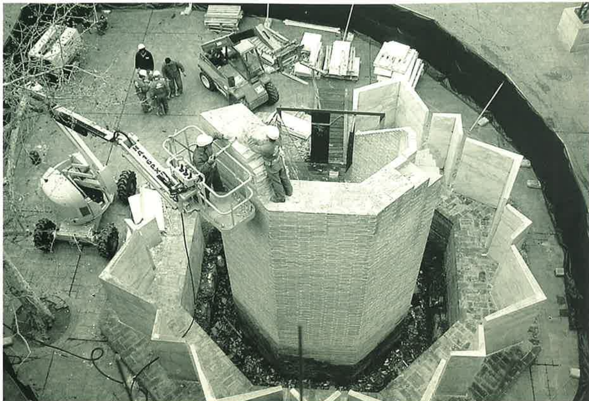
Derribo del memorial de la Torre Nueva
