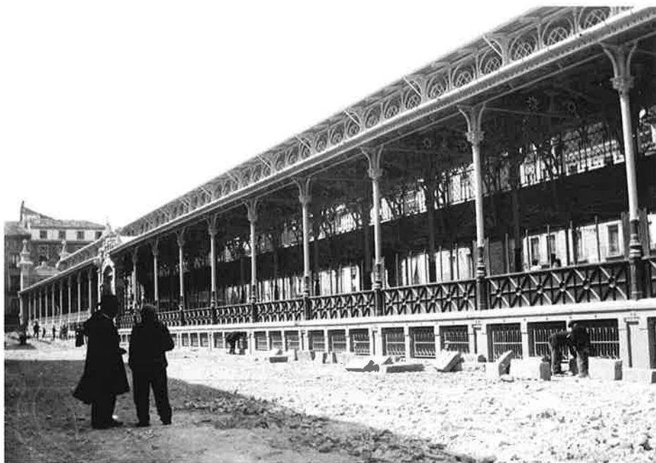
Félix Navarro supervisando la construcción de las obras del Mercado. Archivo Asociación de Detallistas Mercado Central
