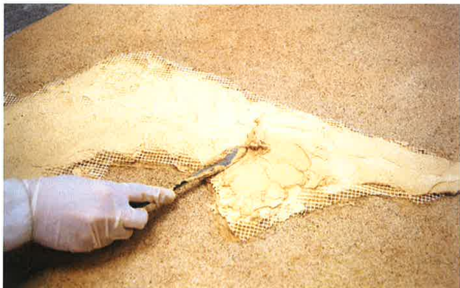
Aplicación del mortero de reposición
