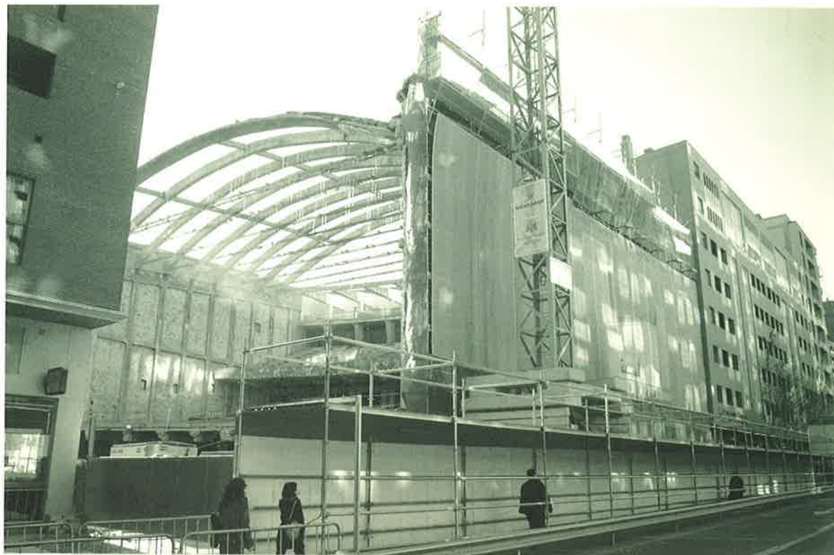
Obras de remodelación en el antiguo Teatro Fleta
