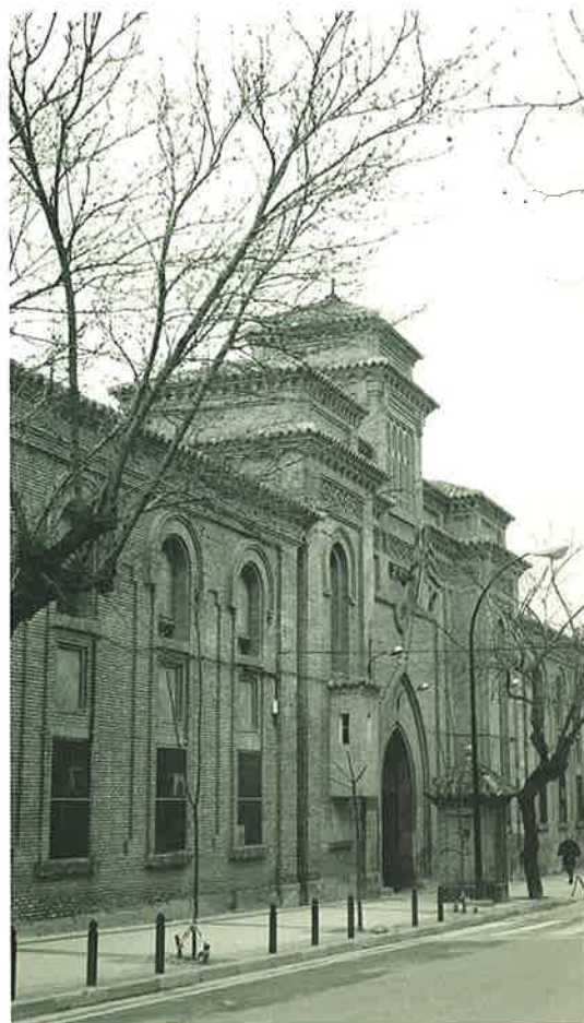
Antigua cárcel de Torrero
