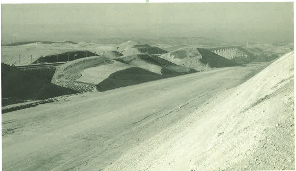
Obras del Cuarto Cinturón
