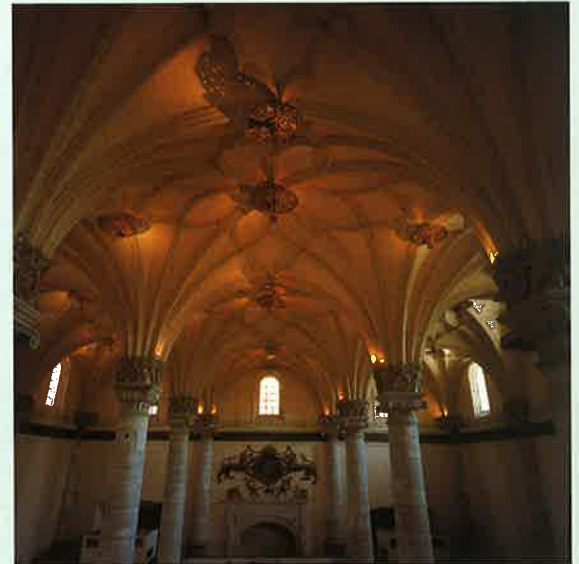
Interior de la Lonja. Es un diáfano y espléndido salón, con sus vistosas columnas anilladas de orden jónico separando las naves, y las bellas bóvedas de crucería estrellada sobre ellas.
