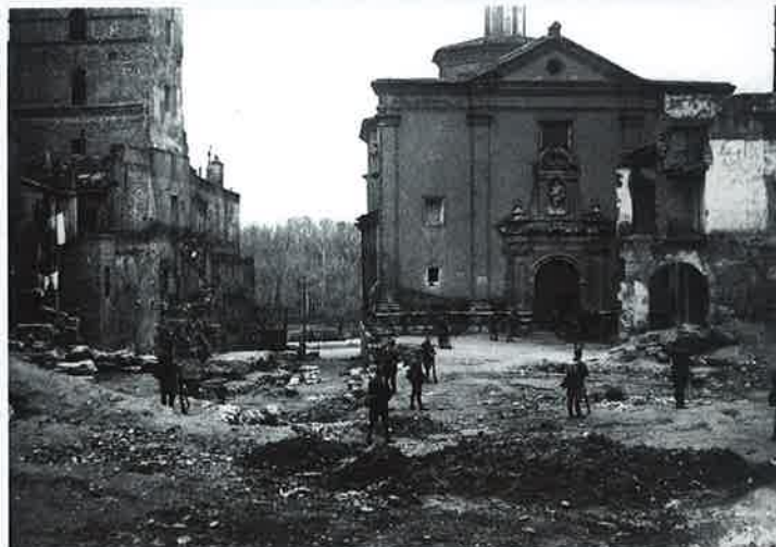
Efectos de un bombardeo de la aviación republicana, que destruyó varias casas en la plaza de Huesca, junto a la iglesia de San Juan de los Panetes. Foto "Heraldo de Aragón".
