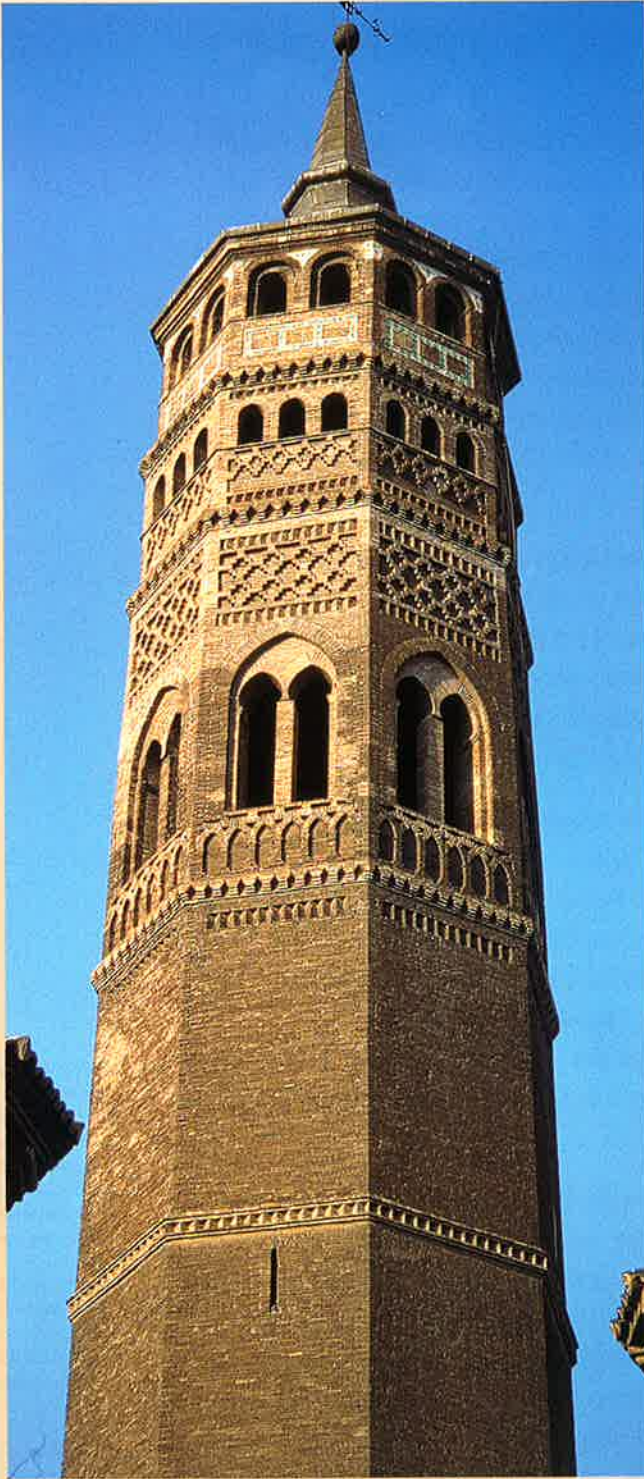
Torre de la iglesia de San Pablo.
