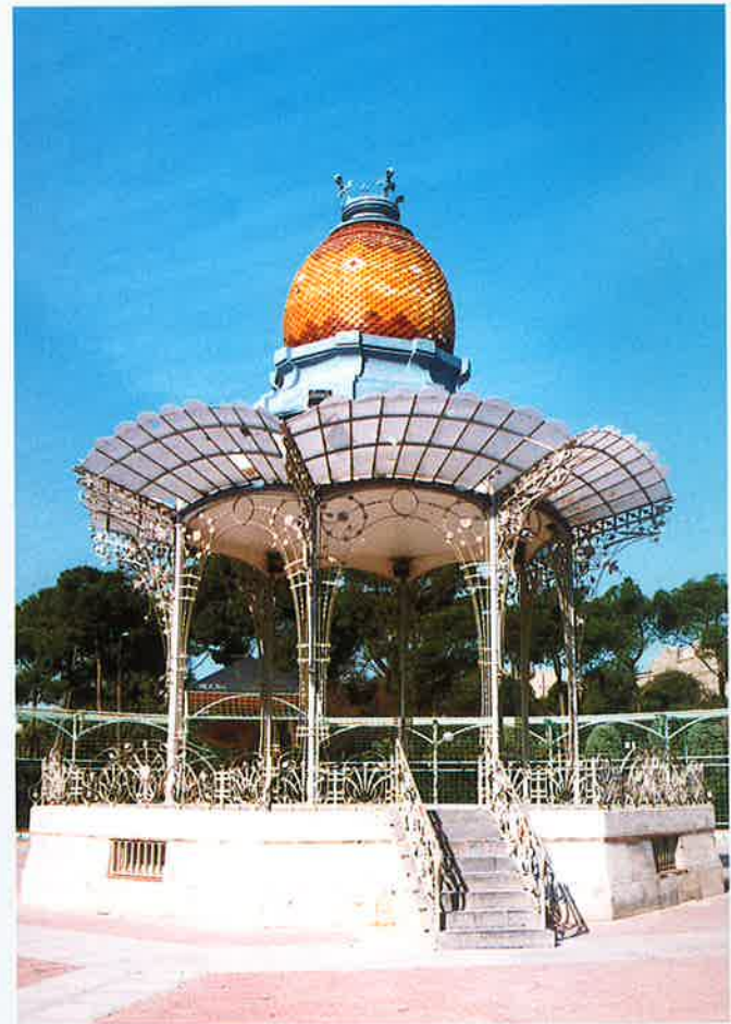
Kiosko de la Música, obra modernista de José y Manuel Martínez de Ubago, hecho para el recinto de la Exposición Hispano-Francesa de 1908 y hoy situado en el Parque Primo de Rivera.
