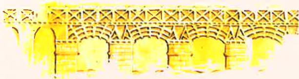
Puente sobre el Danubio representado en la Columna Trajana de Roma. El viaducto era de madera y los pilares de piedra.
