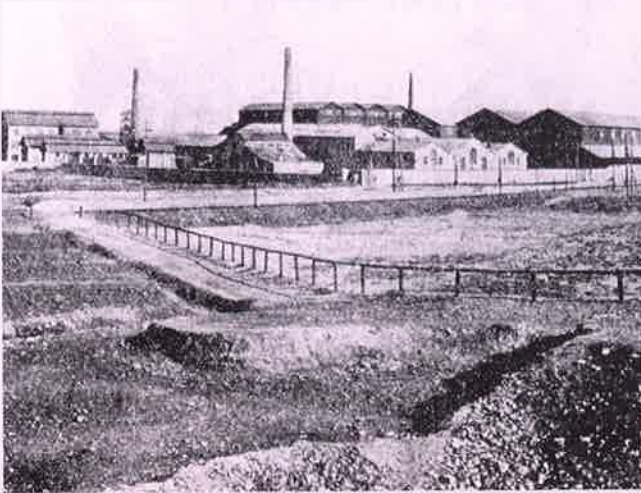
La Industrial Química de Zaragoza, fundada en 1898, que estaba situada en la entrada del actual barrio de la Almozara.
