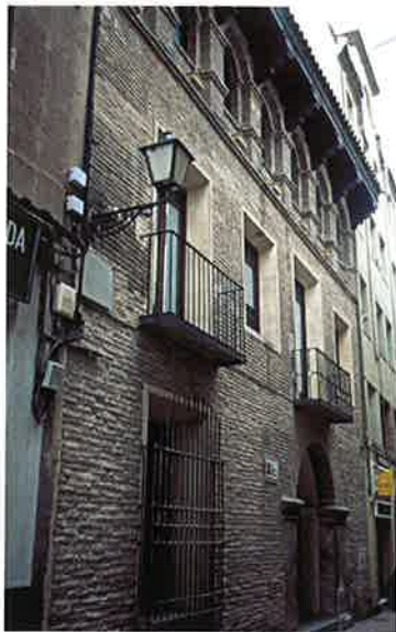
Casa de la 1.ª mitad del siglo XVII en la calle de San Pablo n.º 61, actual sede de la Sociedad Municipal de Rehabilitación Urbana, Zaragoza
