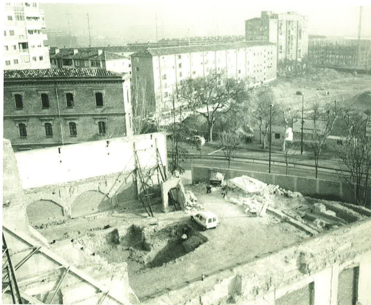
Obras en el convento de San Agustín
