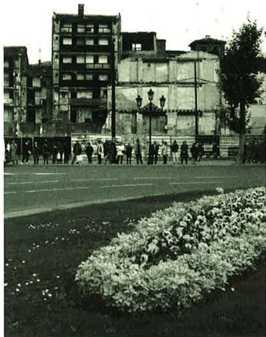
Zona derribada en El Tubo
