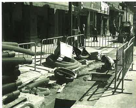
Obras de cableado de la ciudad
