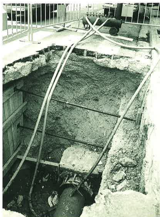
Obras de reparación de la red de aguas
