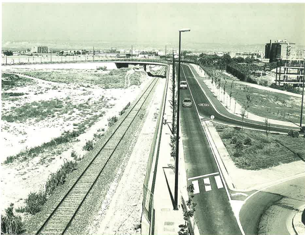
Nuevo acceso a Valdefierro sobre la vía Valencia-Zaragoza
