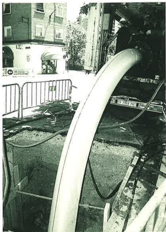
Obras de reparación de la red de aguas
