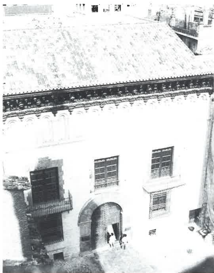
PALACIO DE ARGILLO. Fachada
