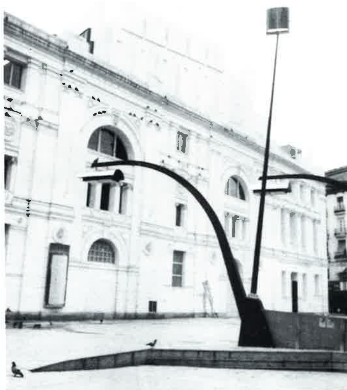
TEATRO PRINCIPAL. Fachada posterior
