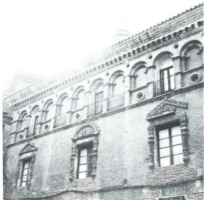
PALACIO DE MORLANES. Vista parcial de la fachada
