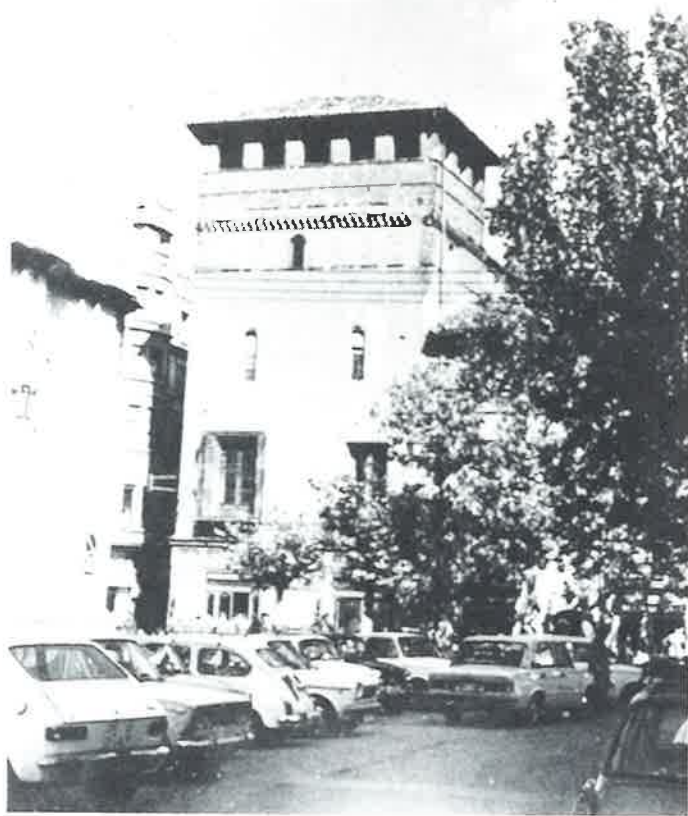
TORREON DE FORTEA. Fachada
