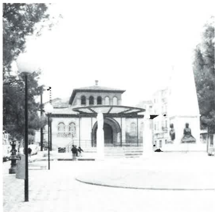
TEATRO DEL MERCADO. Fachada Principal
