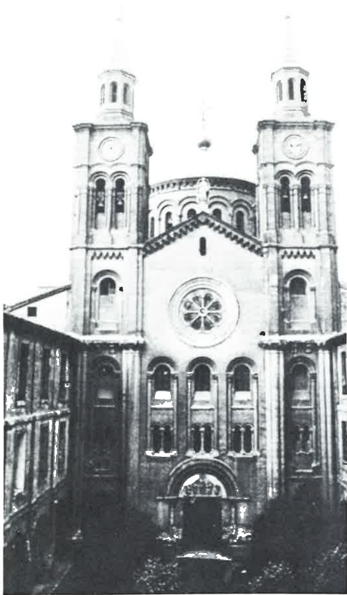
EDIFICIO PIGNATELLI. Fachada Iglesia
