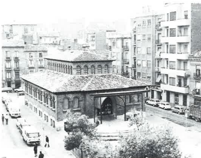
TEATRO DEL MERCADO. Vista de conjunto
