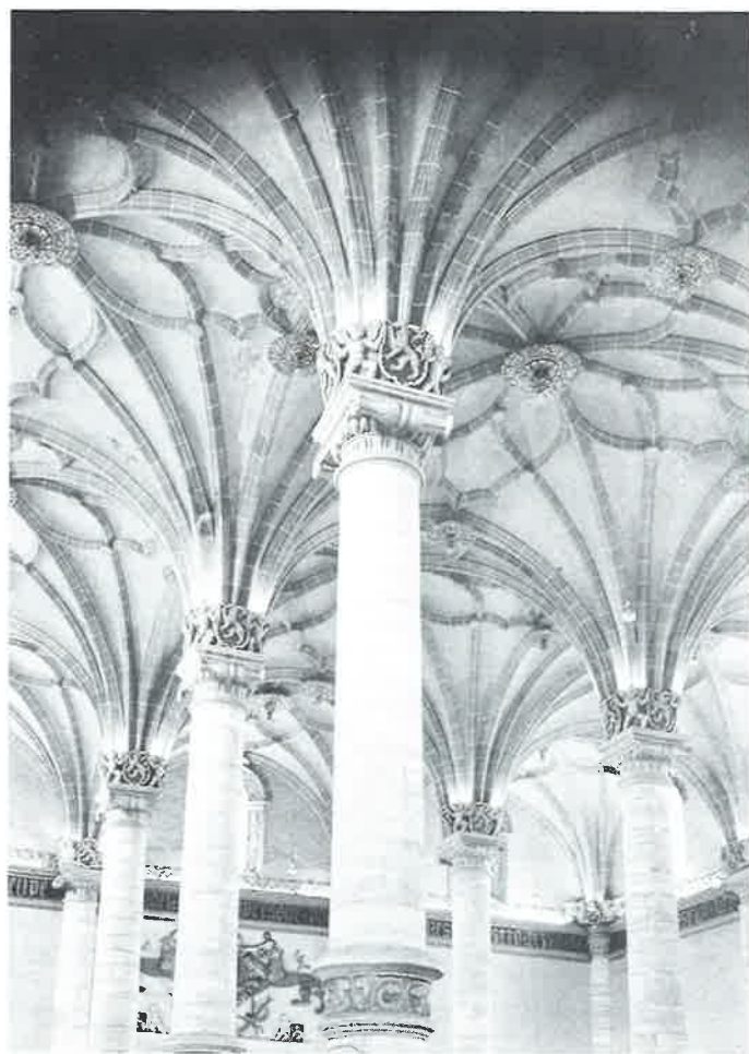
LONJA. Interior Lonja: Bóvedas
