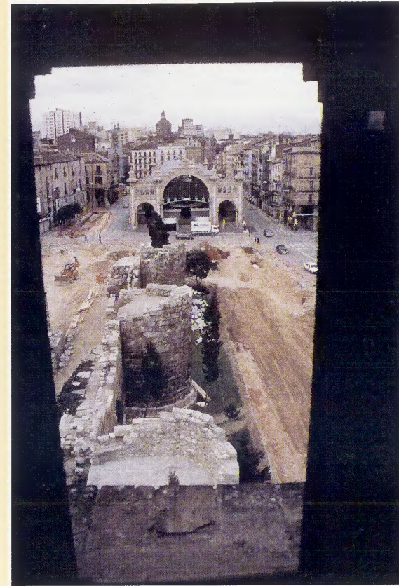
Vista del tramo conservado de la muralla romana junto a la Zuda.
