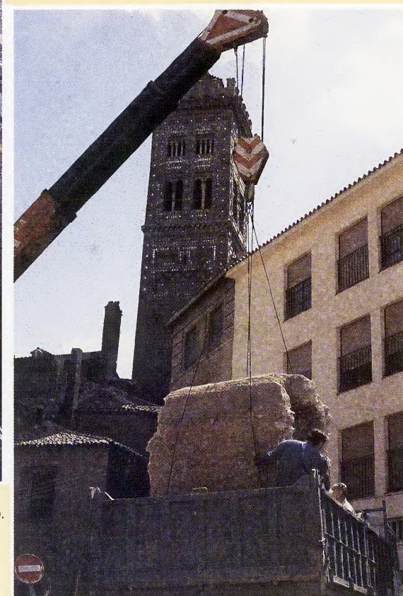
Recuperación de un tramo de cloaca romana.
