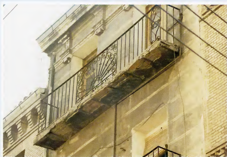
Estado anterior de la fachada y balcones
