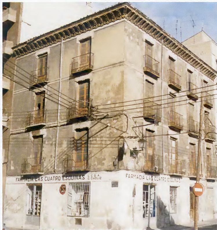
Estado anterior a la rehabilitación
