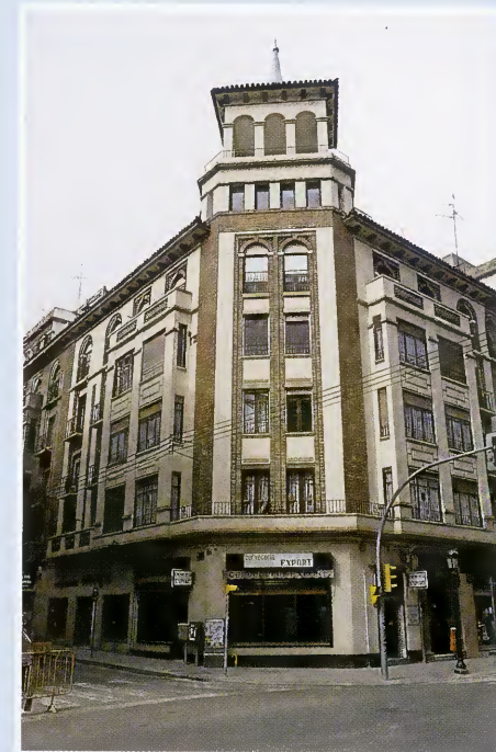
Vista general actual
