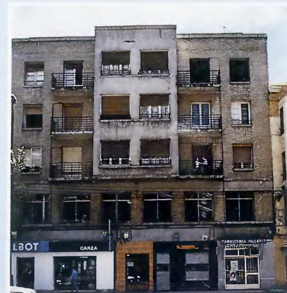
Estado anterior de la fachada
