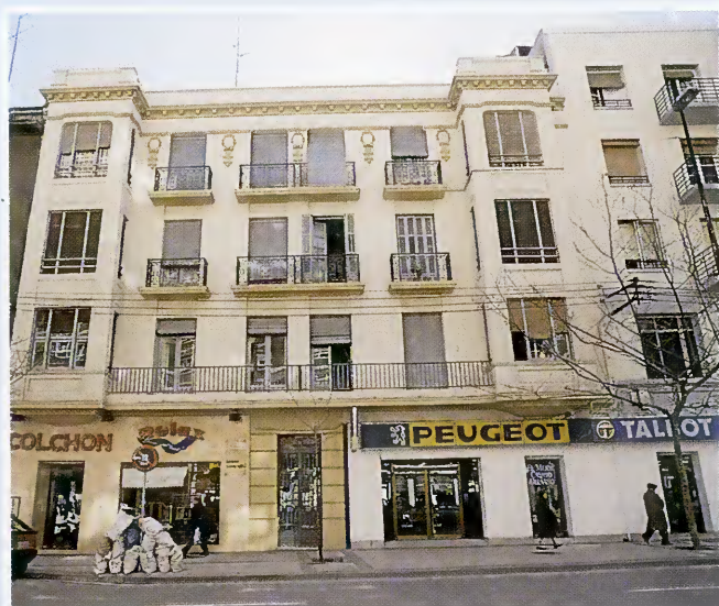
Estado actual de la fachada
