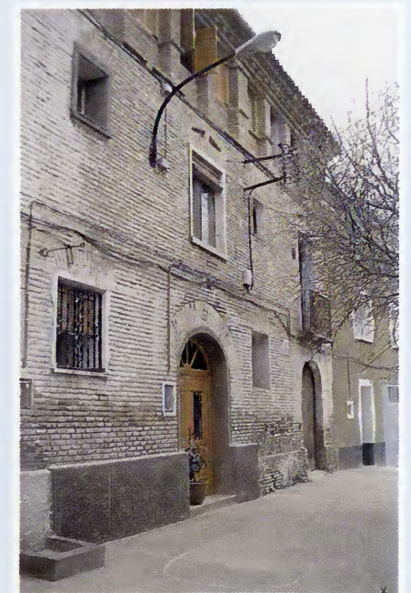
Estado actual de la fachada
