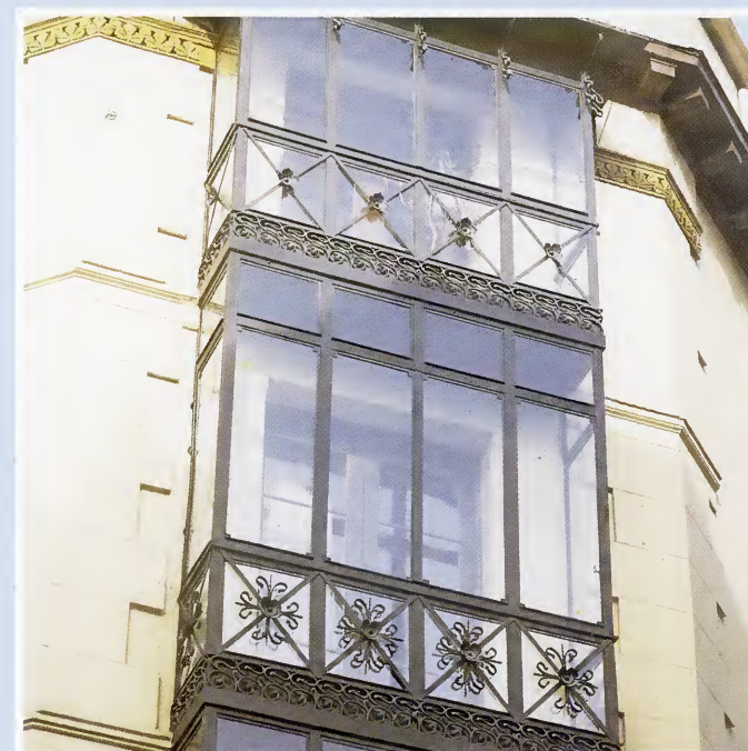
Detalle del mirador rehabilitado
