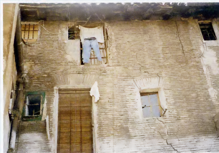
Estado de la fachada interior
