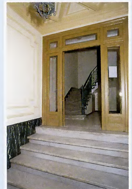
Escalera (estado actual)
