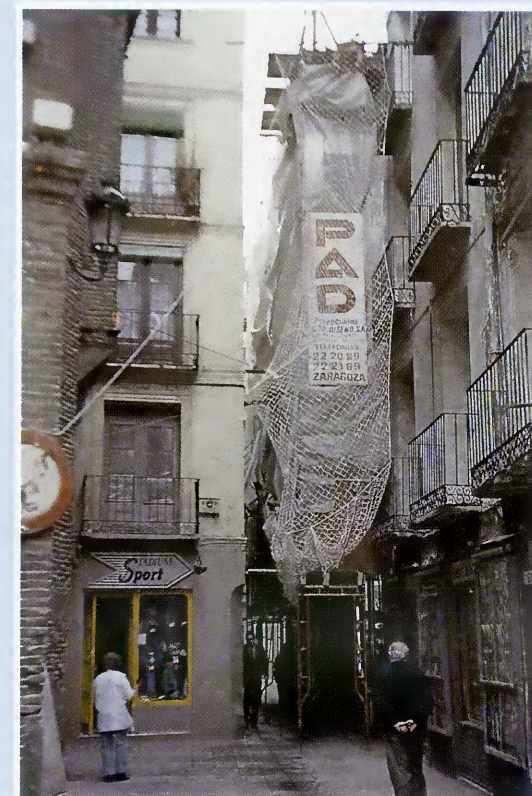
Obras iniciales en fachada
