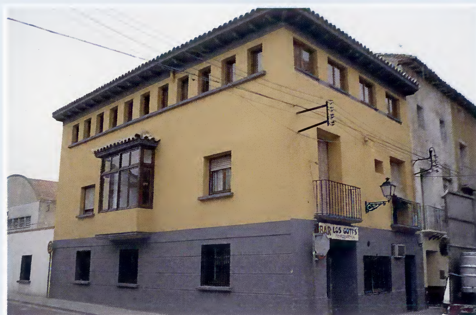
Vista general del edificio rehabilitado
