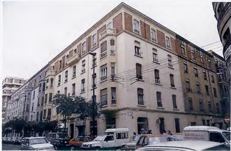
Estado actual de la fachada
