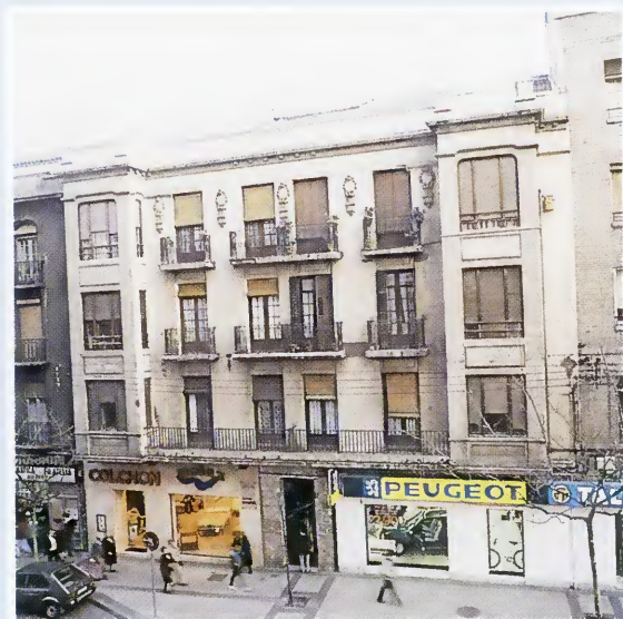
Estado anterior de la fachada
