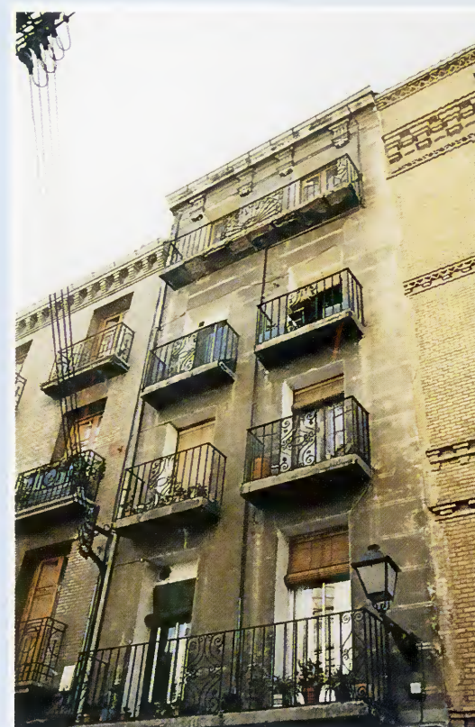
La fachada antes de las obras
