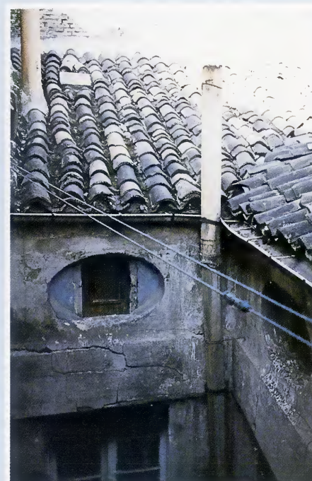
Cubiertas y patio antes
