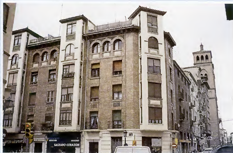
Detalle de la fachada
