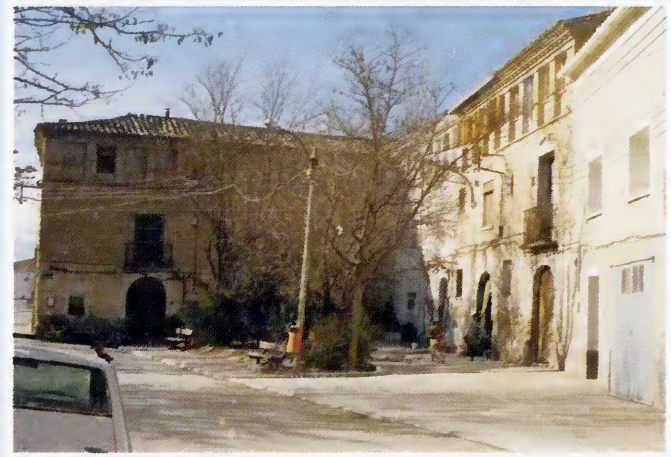
Vista del emplazamiento
