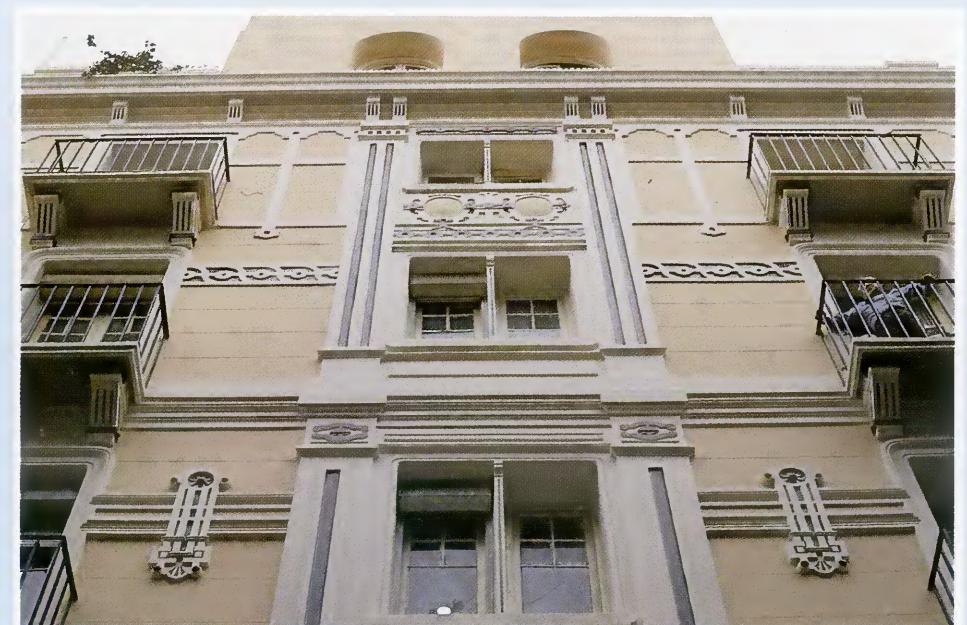
Detalle de fachada ya rehabilitada
