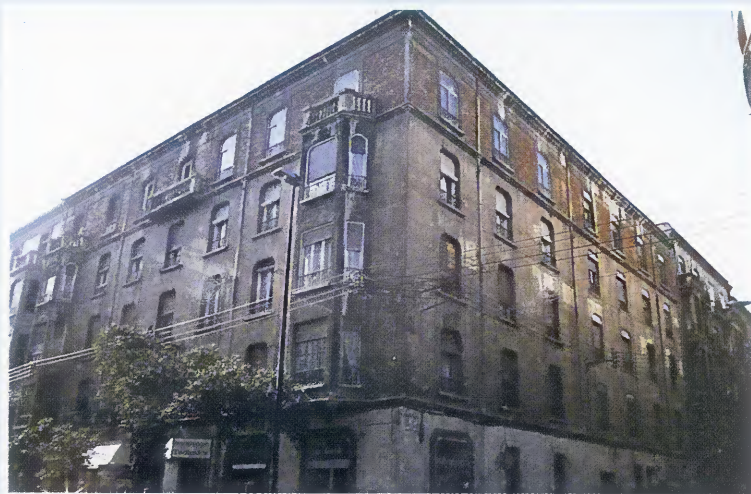
Estado anterior de la fachada
