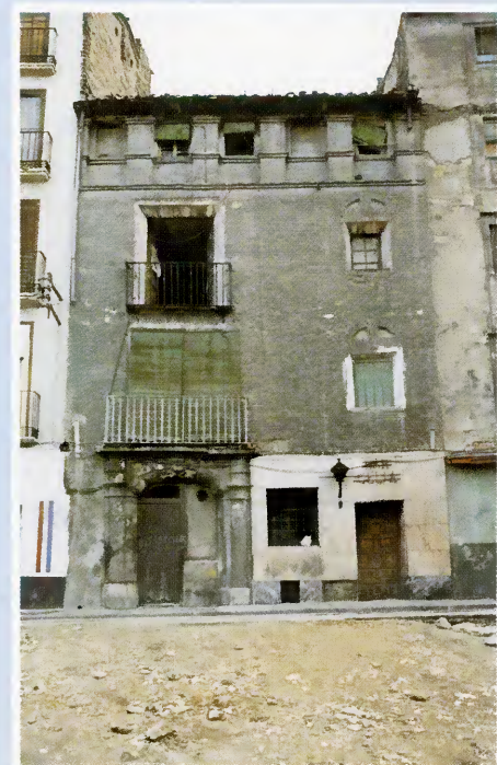
Fachada estado actual
