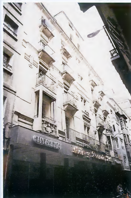
Estado anterior de la fachada
