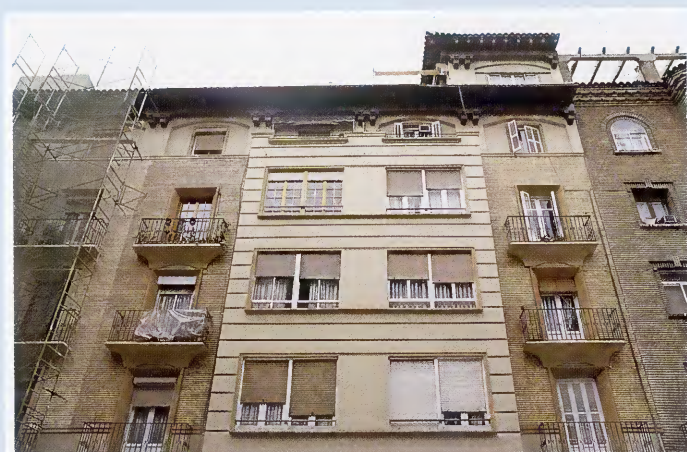
Detalle fachada rehabilitada
