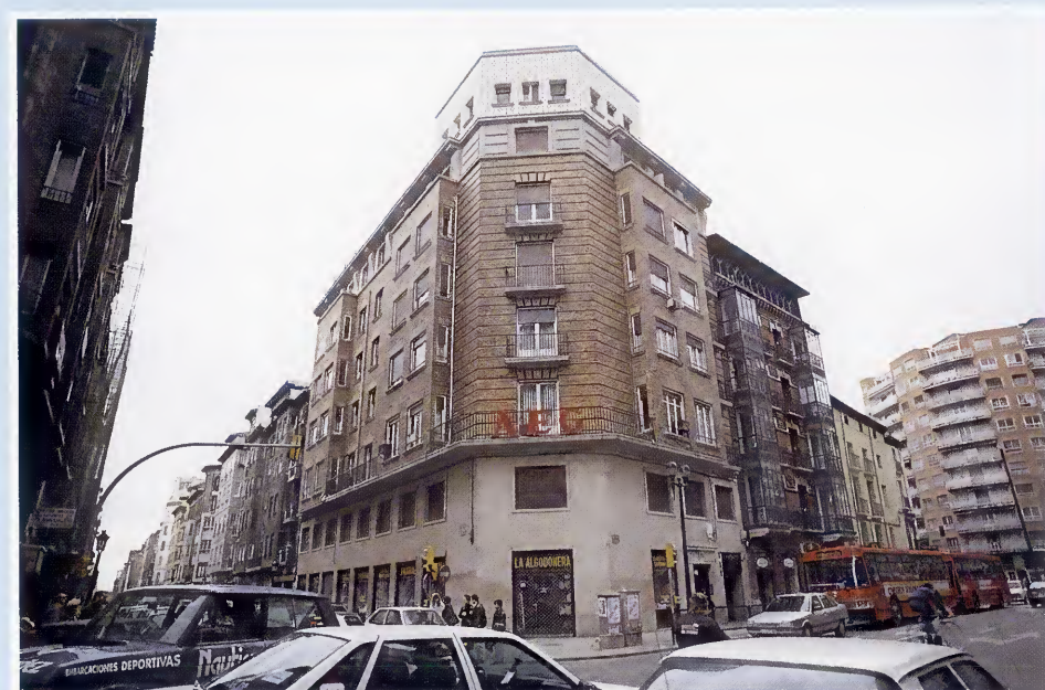
Vista general de fachadas rehabilitadas
