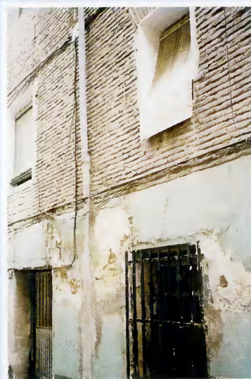
Estado de la fachada calle
