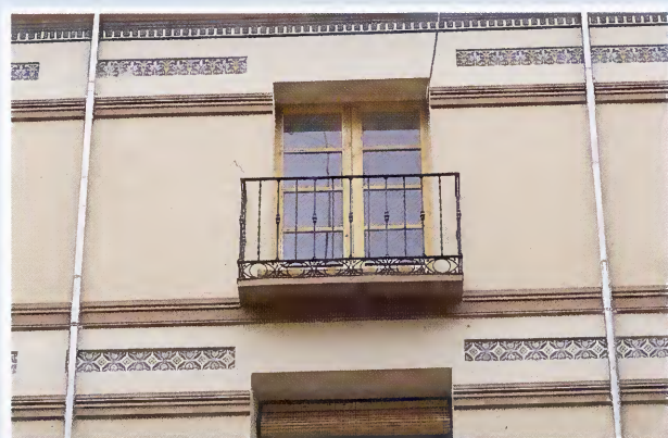
Detalle fachada rehabilitada
