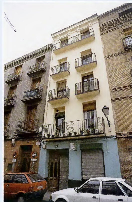
La fachada ya rehabilitada
