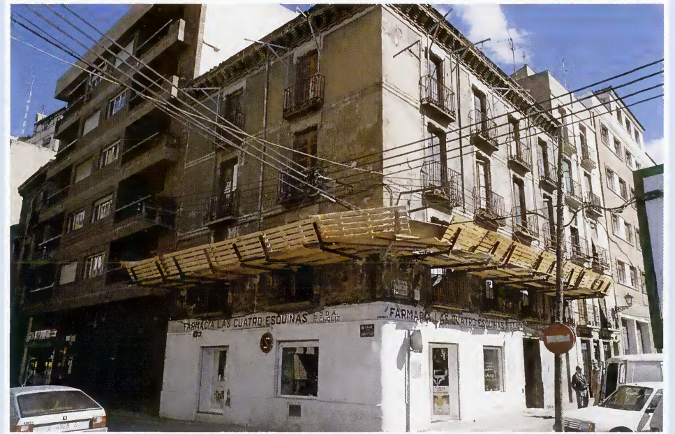
Inicio de obras en fachada
