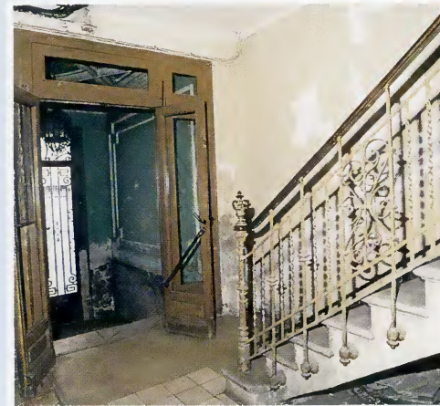
Escalera (estado anterior)
