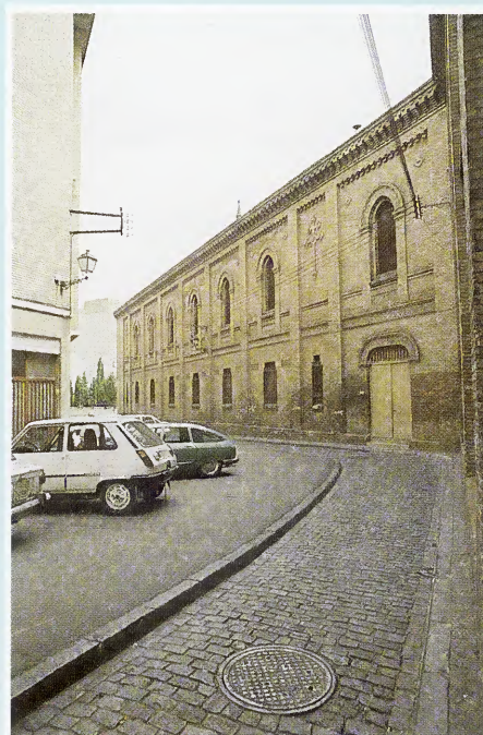
Calle Don Teobaldo, estado actual
