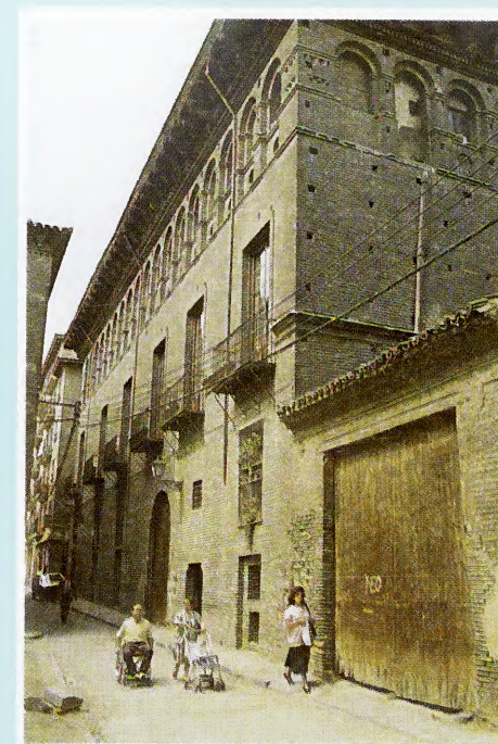
Dormer, estado actual
