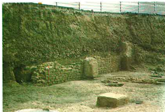
Muro de cierre de las tabernae del Conjunto I. (Foto: J. A. Pérez Casas).
