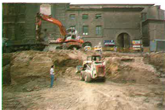
El empleo de importantes medios mecánicos ha facilitado notablemente los trabajos. (Foto: J. A. Pérez Casas).
