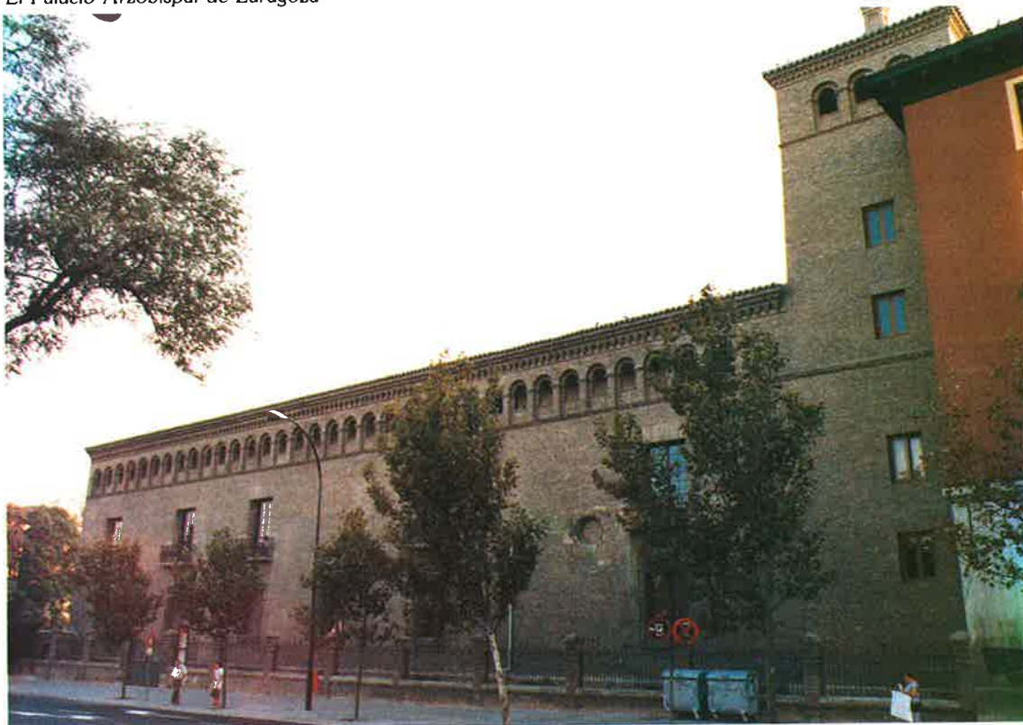
FOTO 7. Vista general de la fachada a la ribera del Ebro, tras la última restauración en la década de los ochenta.
