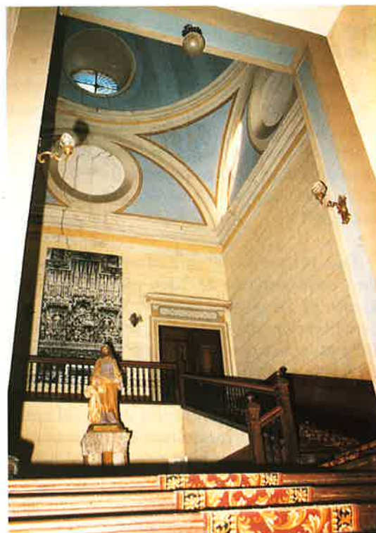
FOTO 6. Vista parcial de la escalera principal con su cúpula sobre pechinas.
