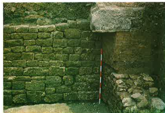
Muro de cierre y muro transversal de sillarejo y adobes. (Foto: J. A. Pérez Casas).
