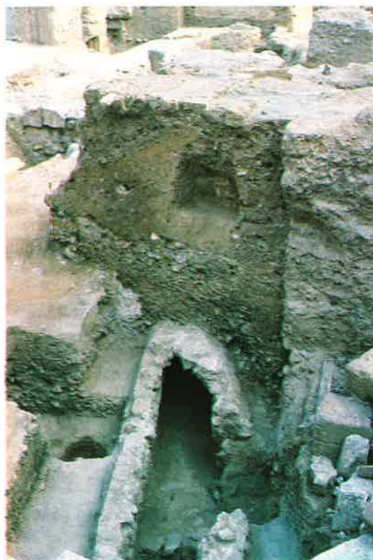
Rellenos acumulados sobre la cloaca más antigua, para el asentamiento del pavimento enlosado del Conjunto II. (Foto: J. A. Pérez Casas).
