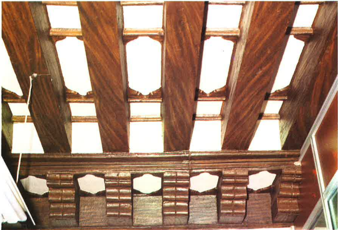
FOTO 1. Vista parcial del alfarje conservado en unas oficinas del palacio arzobispal, en la zona correspondiente al edificio de don Lope Fernández de Luna.
