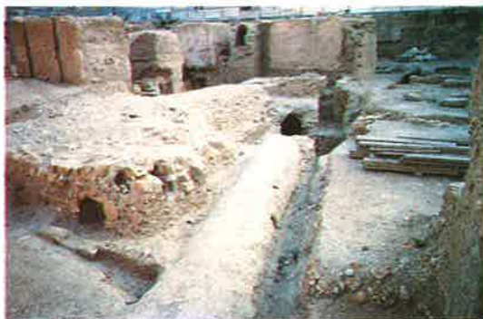
Cloaca de opus vittatum y canalillos afluentes. (Foto: J. A. Pérez Casas).
