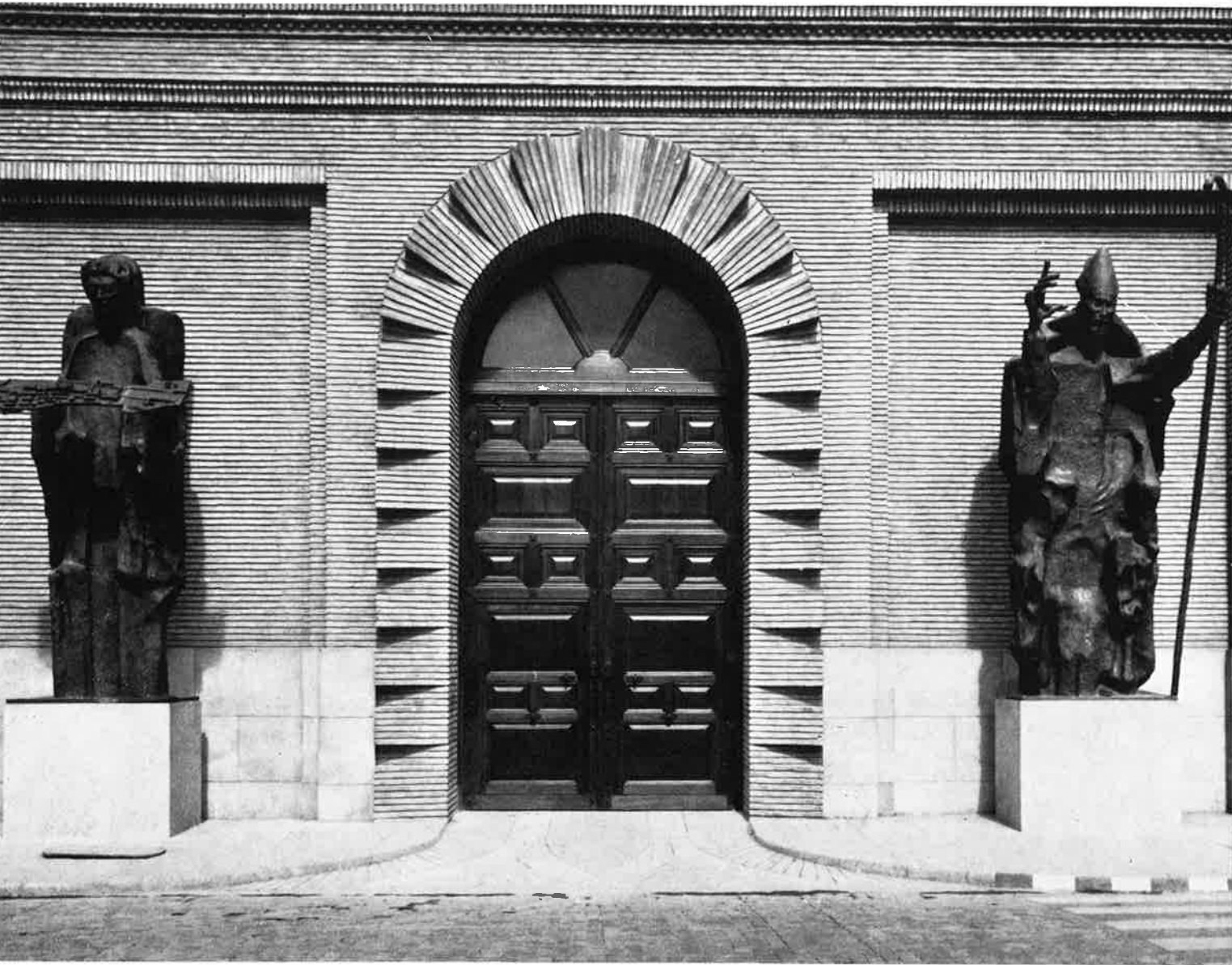
Entrada a la Casa Consistorial.
