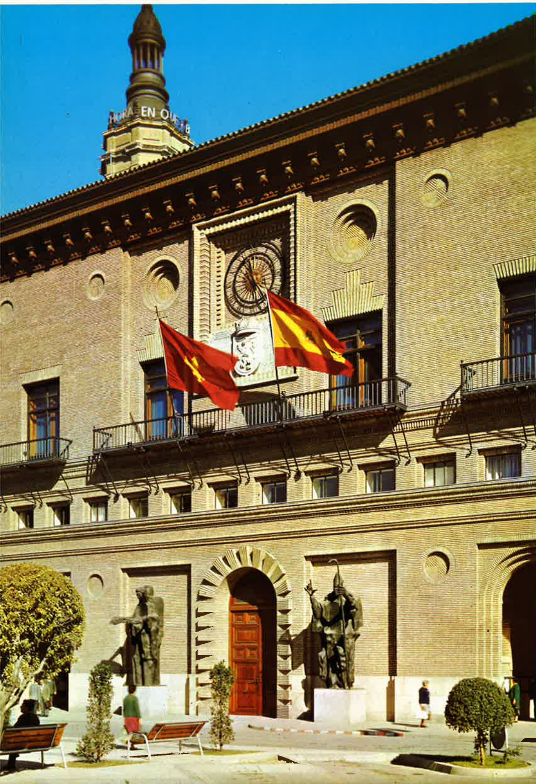
Fachada principal del Ayuntamiento.
