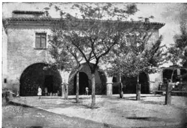
Fabara. — Dos aspectos de la Plaza Mayor y calle de San Juan.
