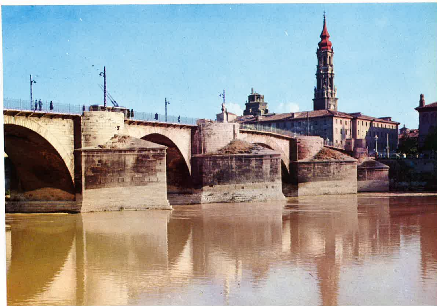
Puente de Piedra y torre de la catedral de La Seo.
