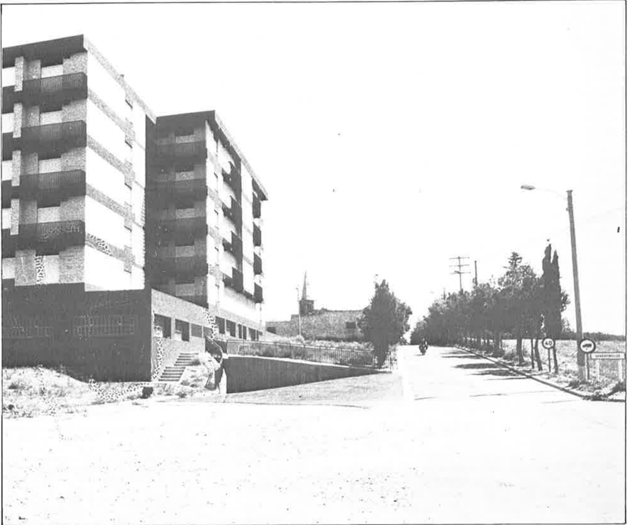
La imagen del núcleo de Garrapinillos, perfectamente adecuado para sus funciones tradicionales de pueblo en la huerta, se ve gravemente turbado por las apetencias de nueva edificación en altura, que le aboca a un futuro entre la «segunda residencia» y el «barrio-dormitorio».
