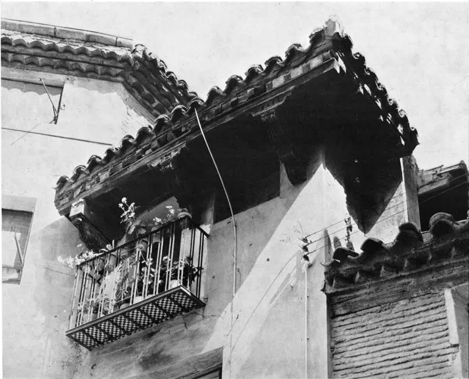
Detalle alero de la casa núm. 2 de la plazuela de San Nicolás
