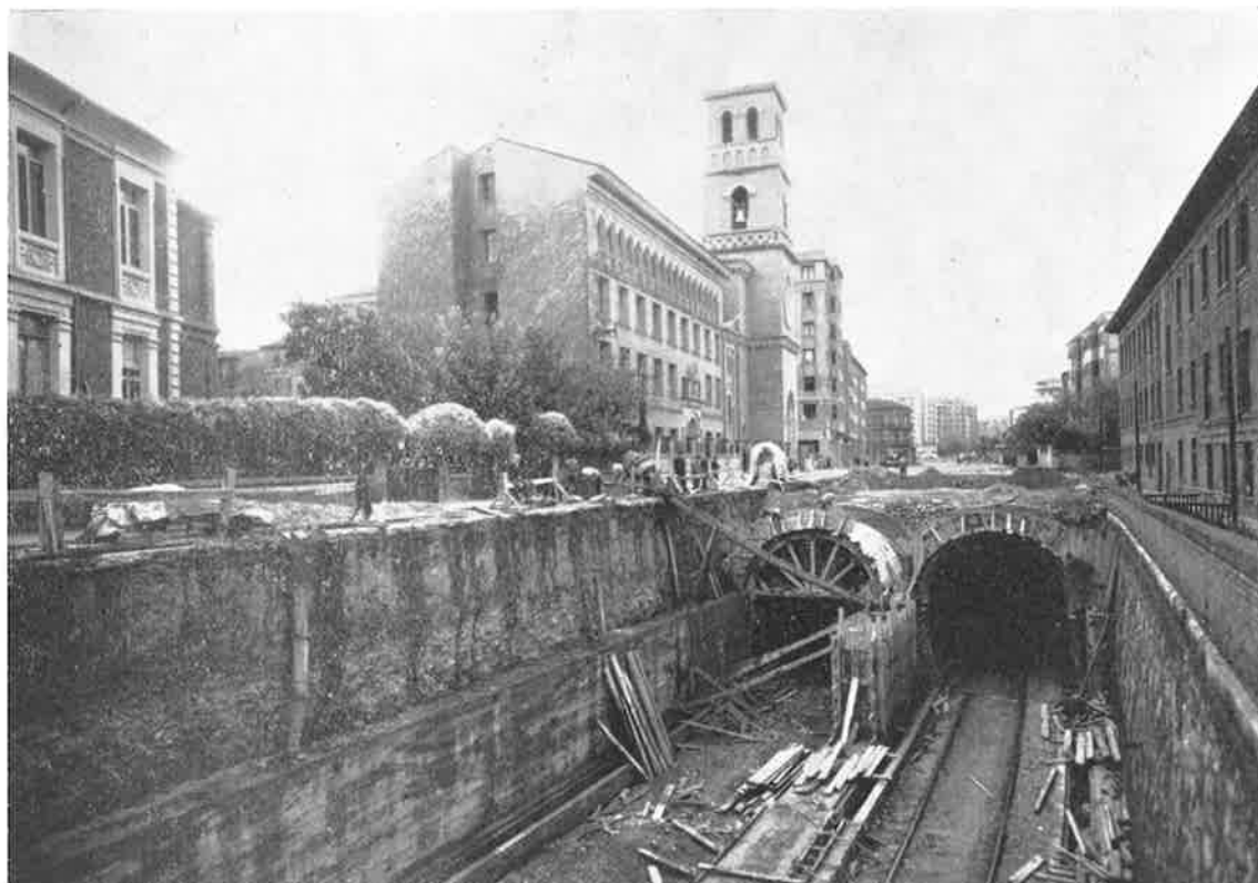
Cubrimiento de la vía del ferrocarril
