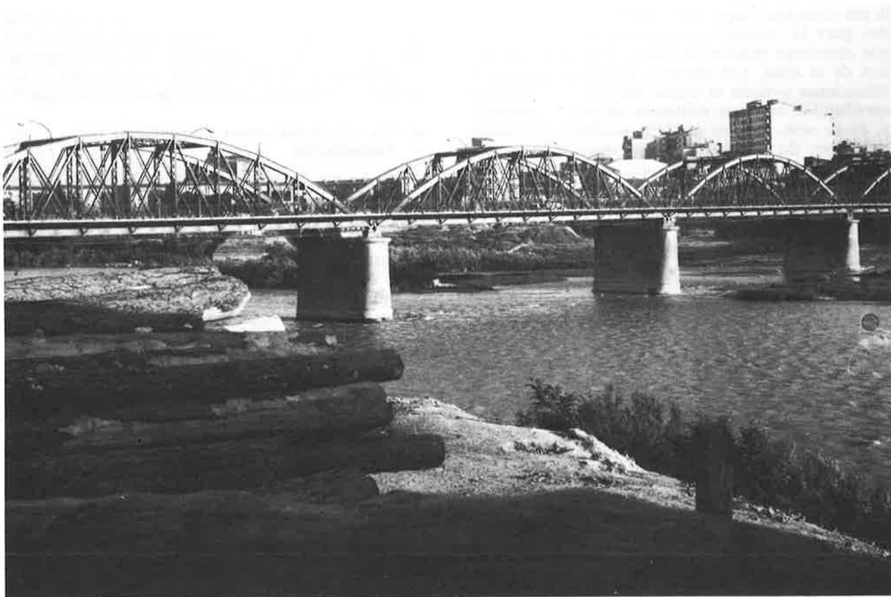
Puente de Hierro.
