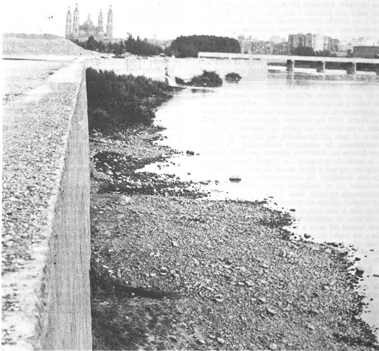
Obras de protección de la margen izquierda
