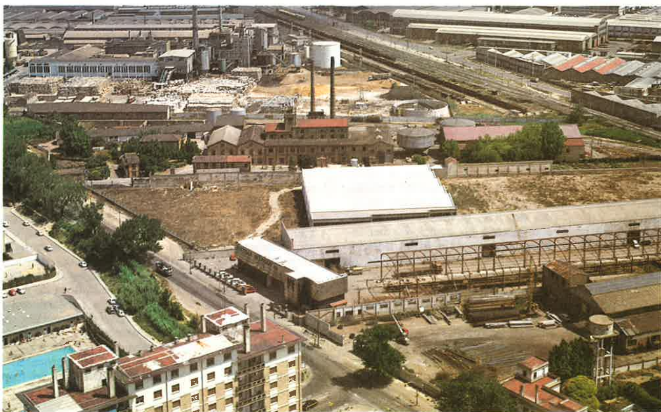
Instalaciones industriales junto al ferrocarril.
