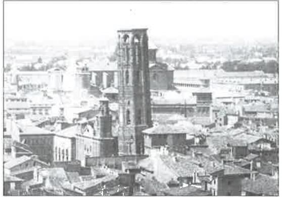
Las dimensiones comprobadas en su base son de 2,05 m de anchura en su pared exterior, un pasillo que recoge la escalera de 1,22 m, un ancho del muro de la contratorre, de 0,70 m y un hueco interior central de 3,25 m. La altura hasta el suelo de los balconcillos superiores, era de 50 m y el desplome en ese punto, de 2,37 m; el remate hasta la veleta alcanzaba una altura de 80,60 m.
