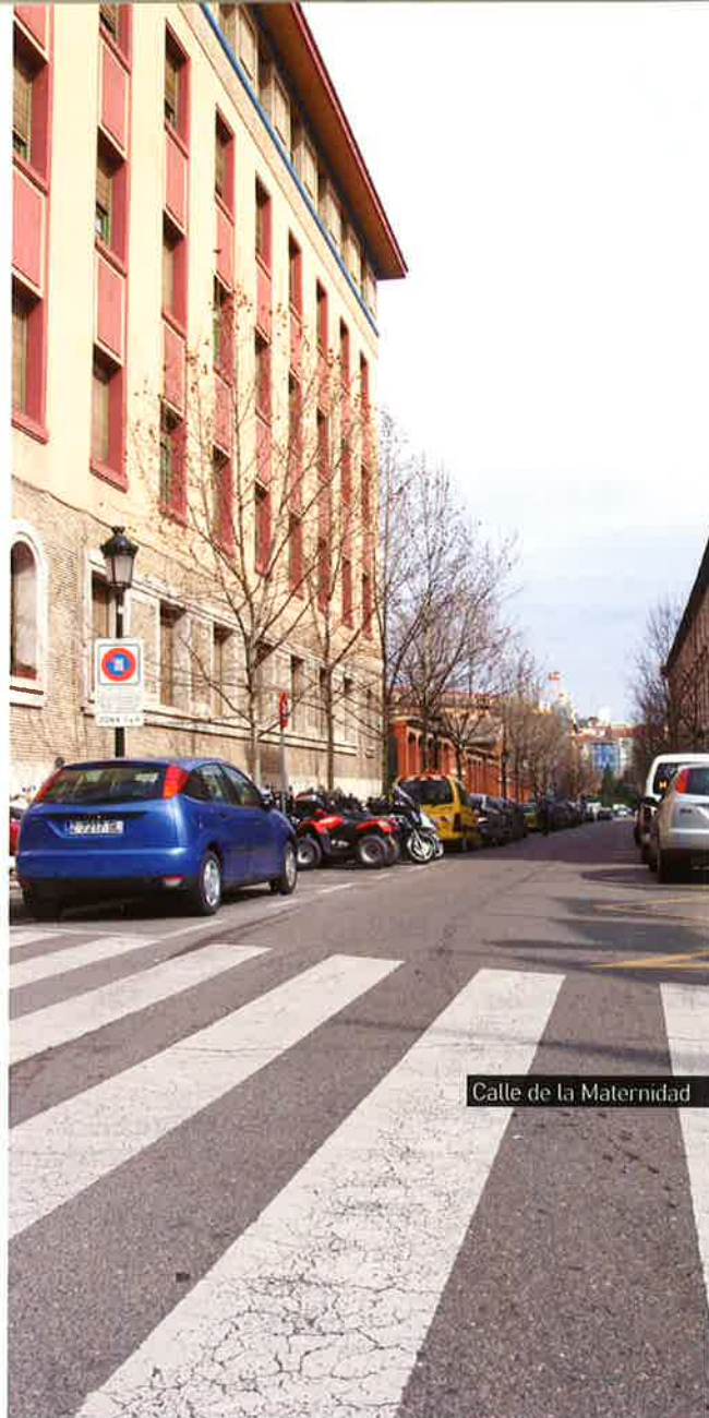
Antiguo edificio de la Maternidad que daba nombre a la calle.
