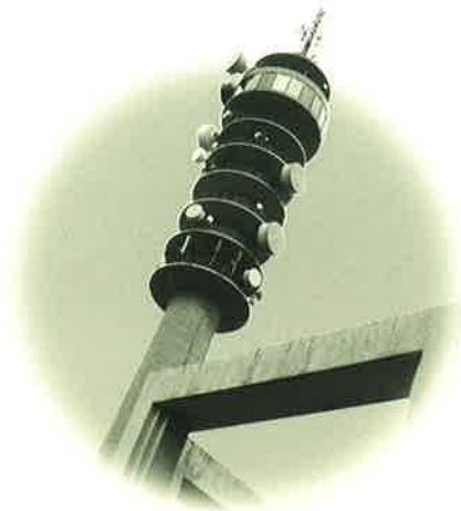
Torre de telecomunicaciones de Telefónica
