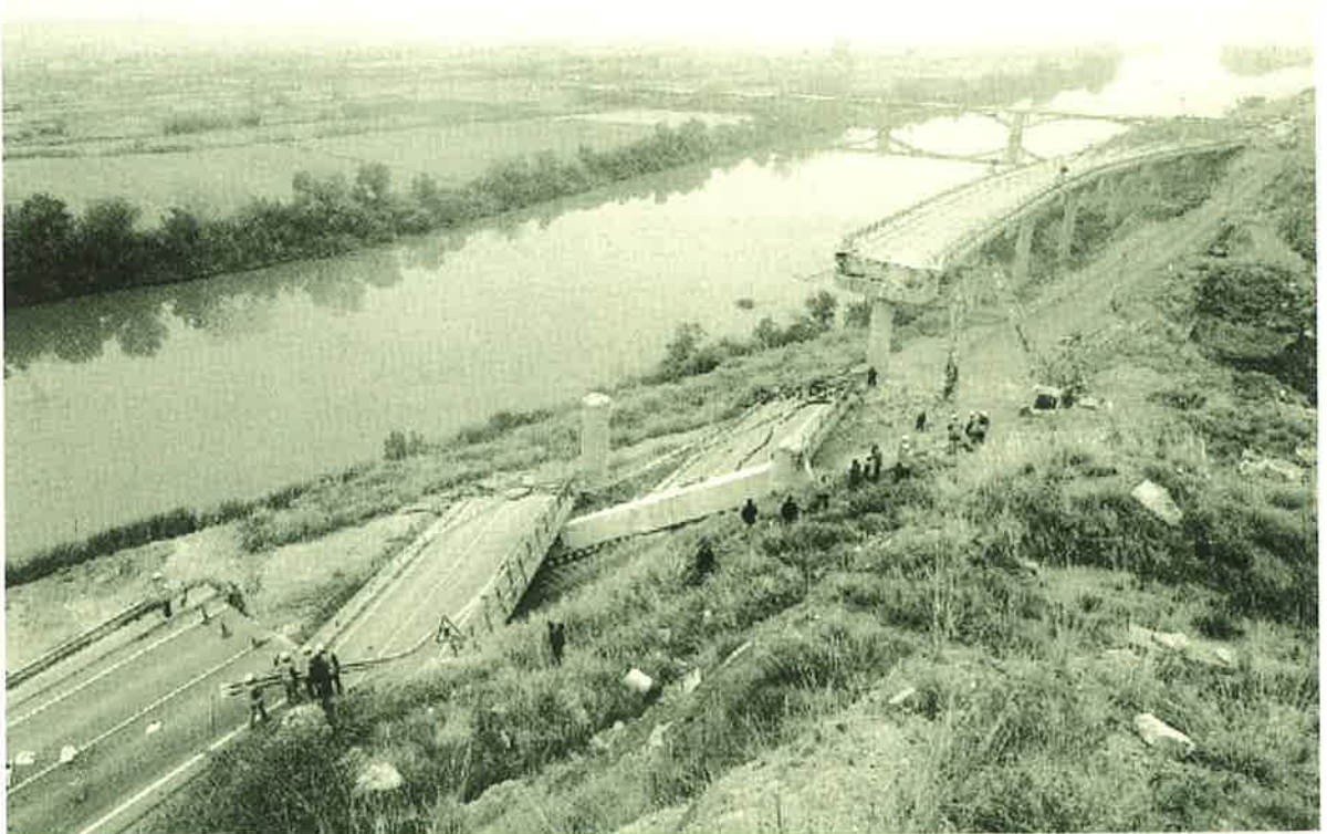
Voladura controlada del puente de la carretera A-221
