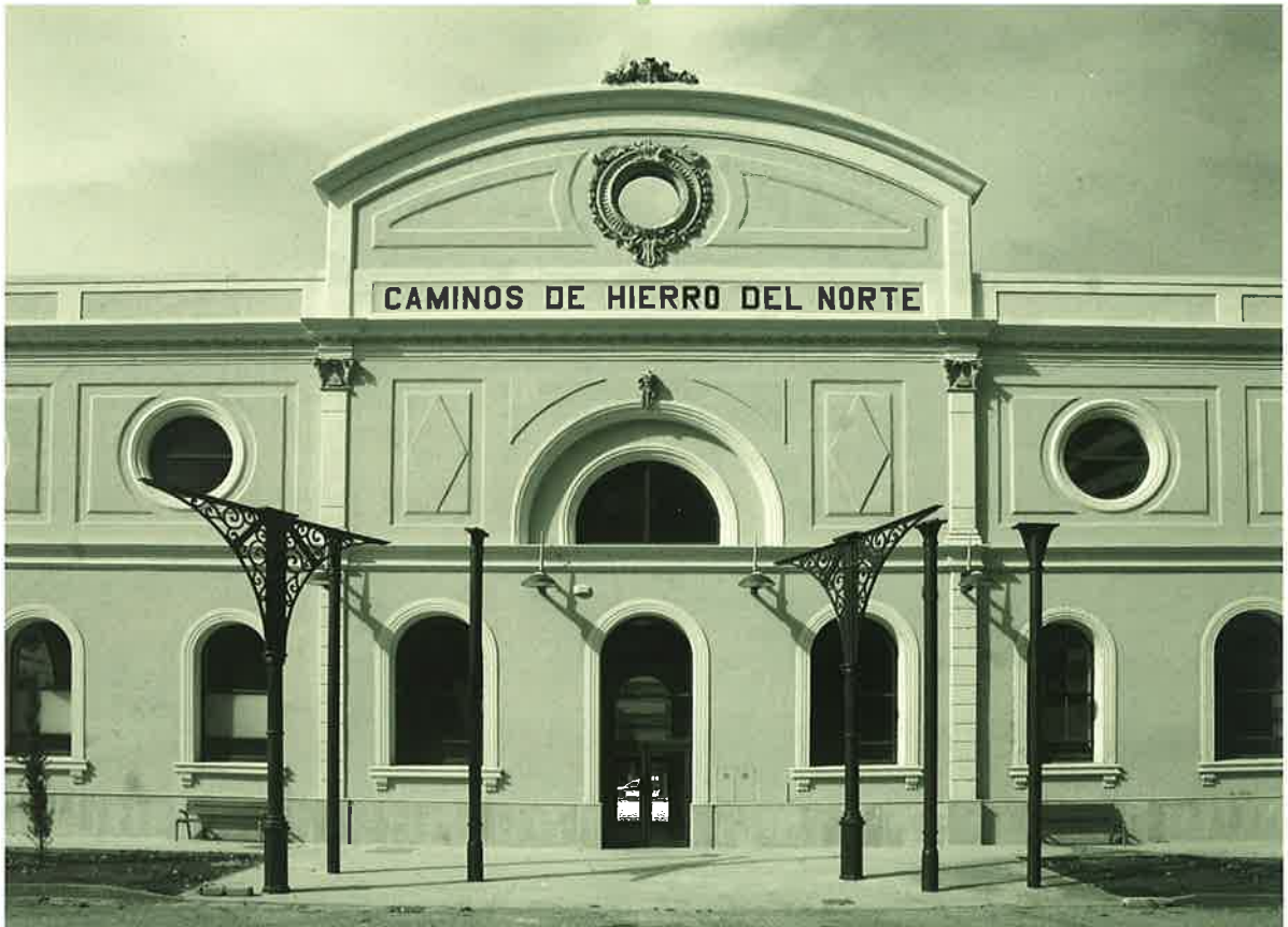
Centro Cívico en la antigua Estación del Norte
