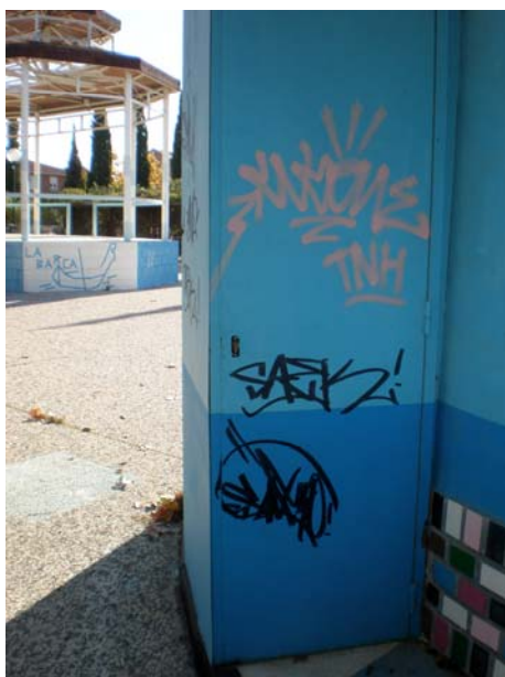
Fotografía nº 35: Aseo Quiosco Bar
