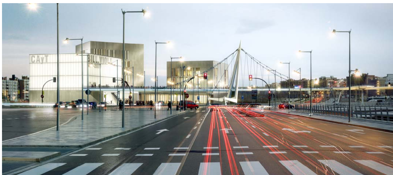
Vista del Centro de Arte y Tecnología desde la Autopista
