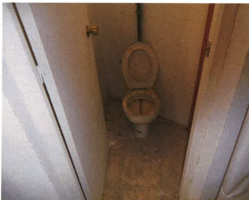
Estado aseo interior
