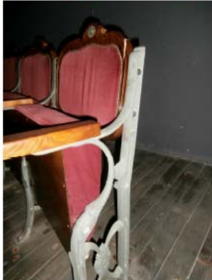
Butacas planta cuarta. Detalle soporte fundición.
