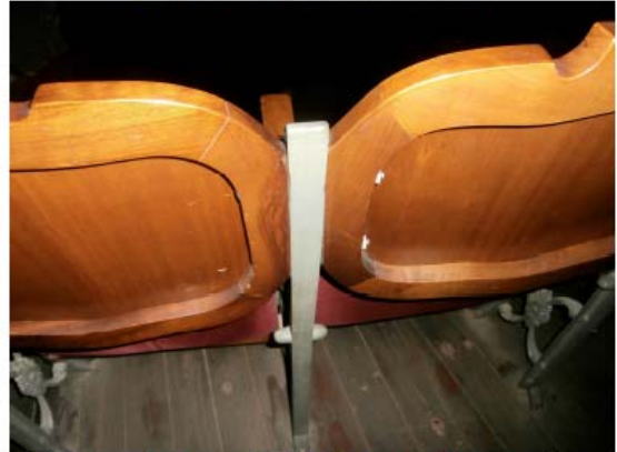
Butacas planta cuarta. Detalle ensamble respaldos.
