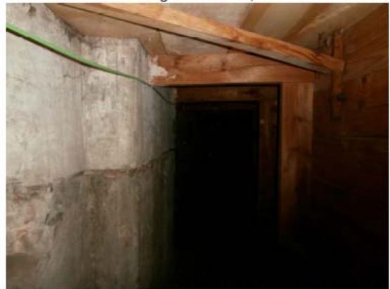
Estructura grada lateral, interior.
