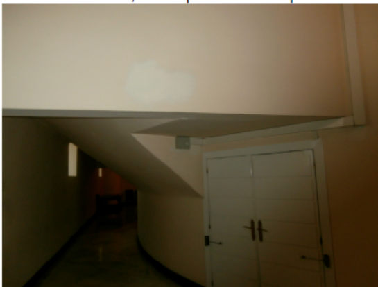
Acceso a gradas cuarta planta
