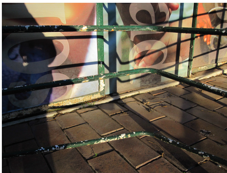
(007) – ESTRUCTURA PERIMETRAL DOBLADA (3)
