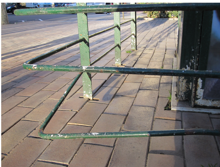
(006) – ESTRUCTURA PERIMETRAL DOBLADA (2)
