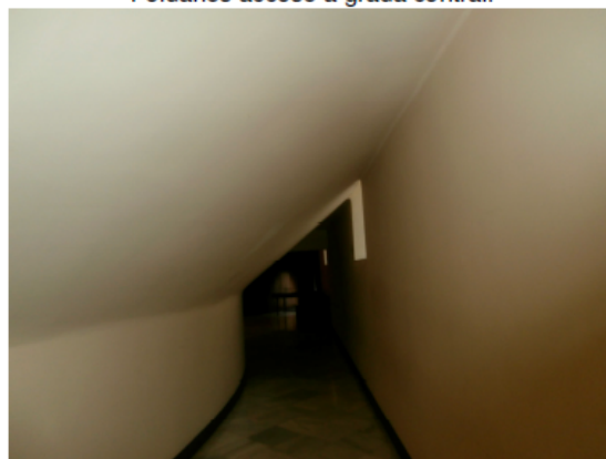
Pasillo bajo grada central cuarta planta.
