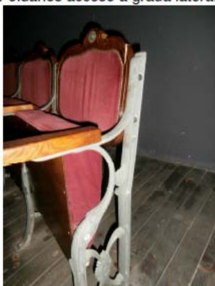
Butacas planta cuarta. Detalle soporte fundición.
