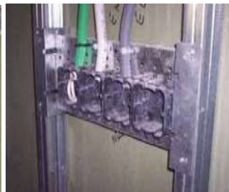
Empleo de cajas adecuadas para elementos constructivos de entramado autoportante.
