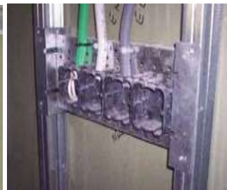
Empleo de cajas adecuadas para elementos constructivos de entramado autoportante.
