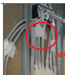
Contactos rígidos entre las instalaciones y cajas de mecanismos y registro con la hoja de fábrica.
