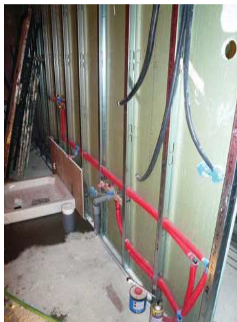
Instalación correcta de las tuberías entre los perfiles de las placas de yeso laminado
